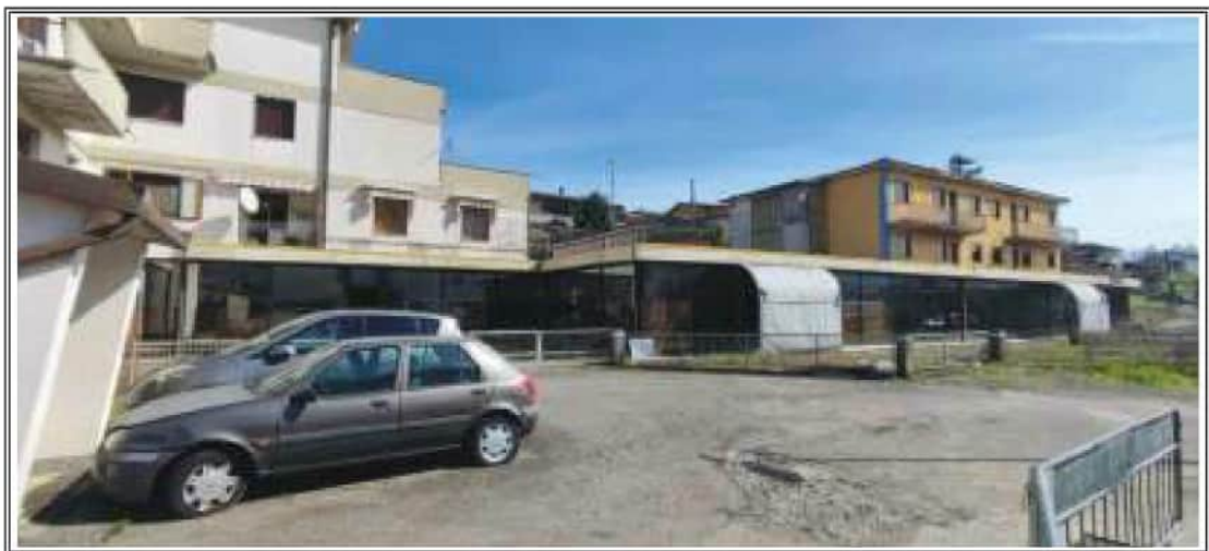
Foto n. 6 – Vista del codominio da Via Germania
