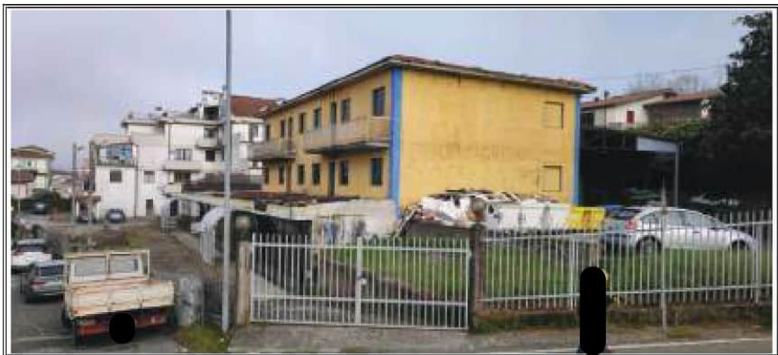
Foto n. 2 – Vista del condominio angolo SUD
