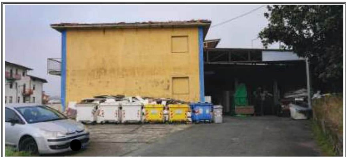
Foto n. 3 – Vista del condominio facciata SUD/EST
