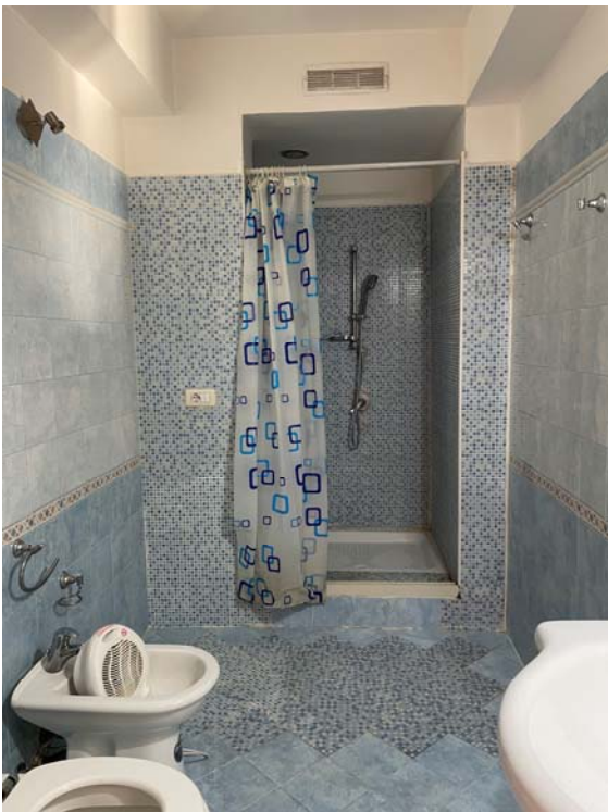
Vista del servizio igienico
