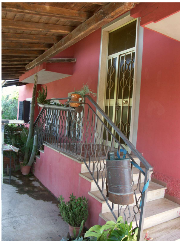
Portone di ingresso alla scala
