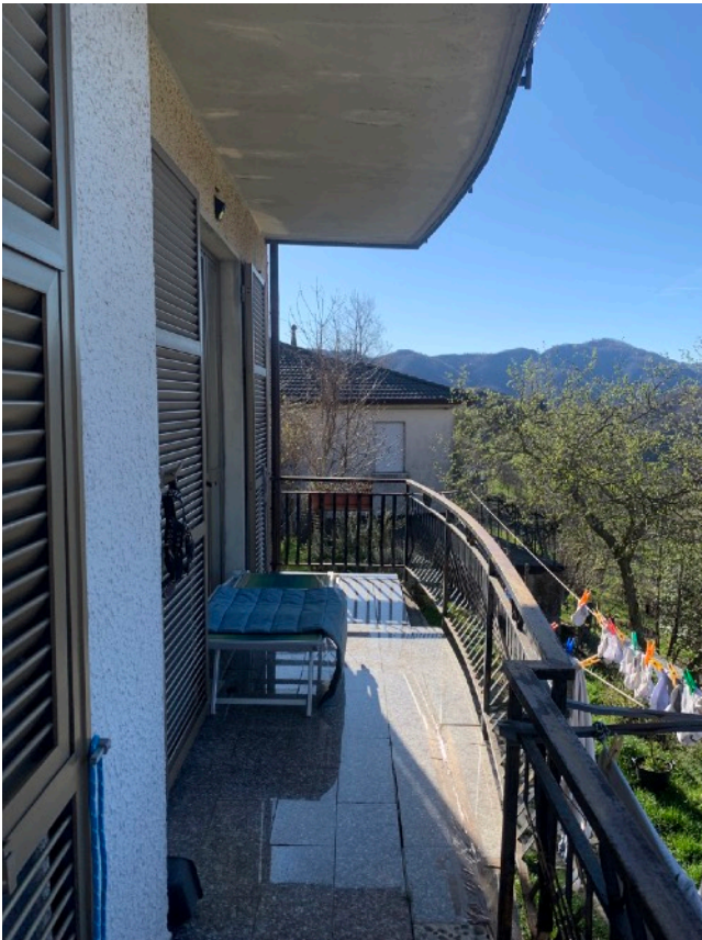
FOTO E7_ Balcone lato fronte SUD-OVEST
