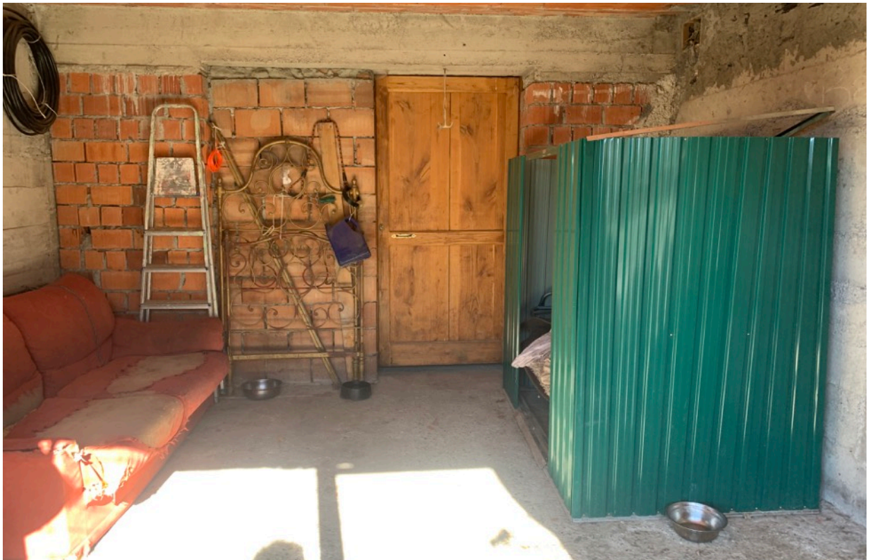
FOTO 10 _INTERNO garage/deposito (livello seminterrato )
