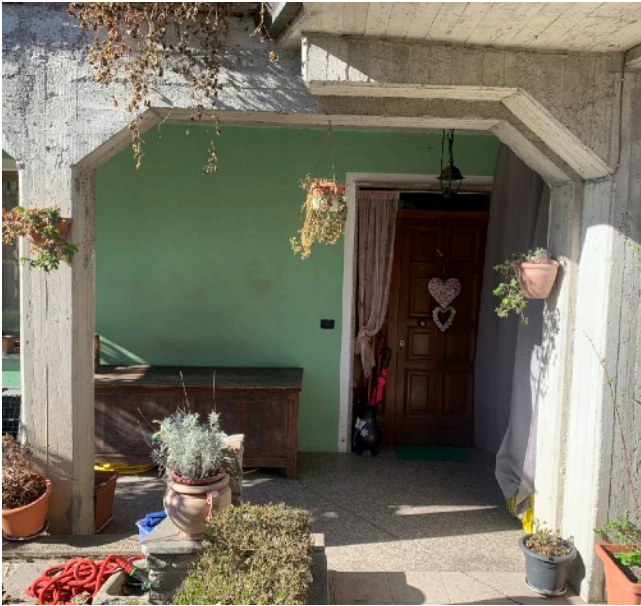
FOTO E2_ fabbricato, ingresso all'unità abitativa lato NORD_EST
