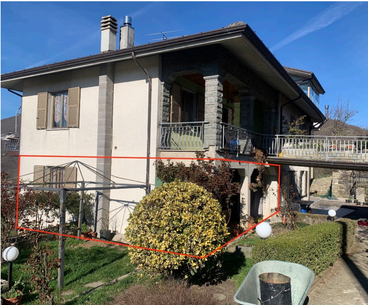
FOTO E1_ fabbricato, fronte principale lato NORD-EST
