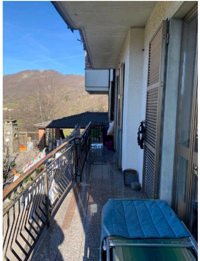
FOTO E8_ Balcone lato fronte SUD-OVEST
