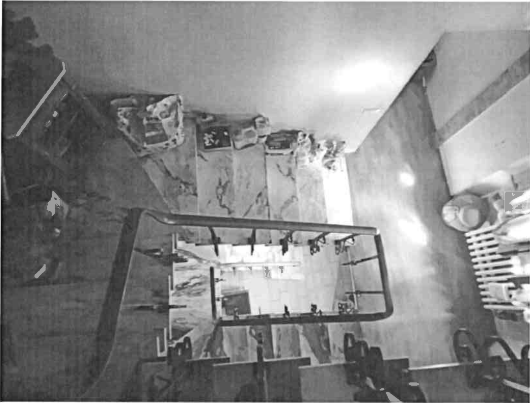
SCALA DA PIANO PRIMO A PIANO SOTTOTETTO
