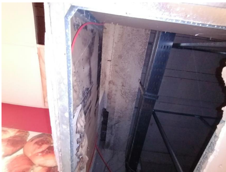
Giunto tecnico con infiltrazioni
