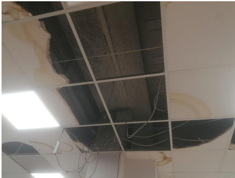
Giunto tecnico con infiltrazioni
