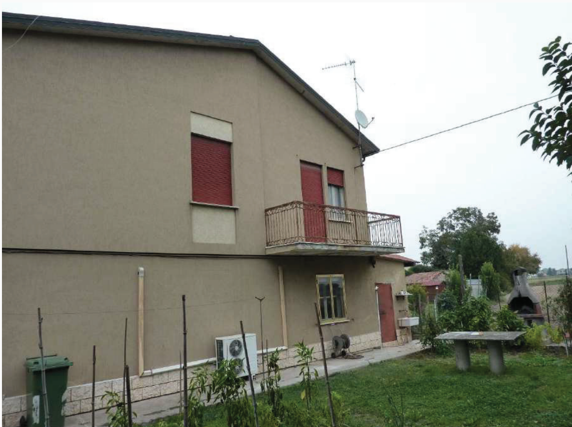
FOTO 8 _ PARTICOLARE PROSPETTO SUD DALLA CORTE COMUNE
