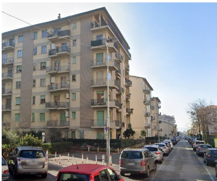
VISTA DA VIA BARACCA
