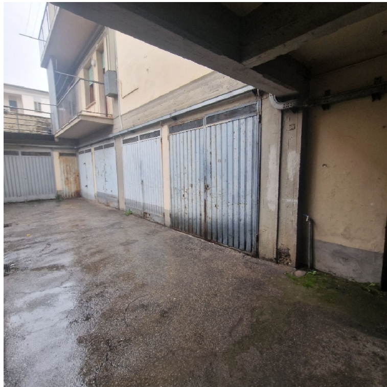
VISTA 14A – BOX AUTO, VISTA ESTERNA
