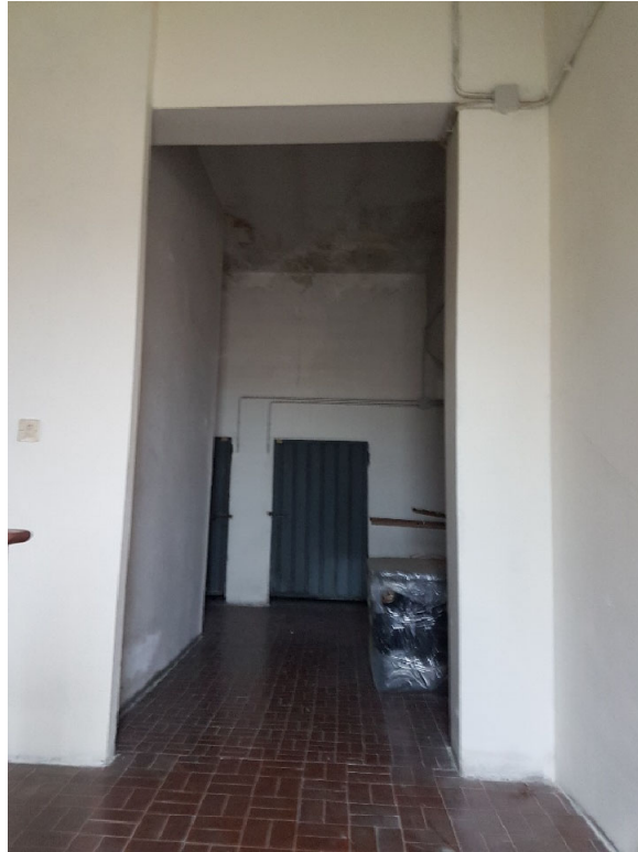
VISTA 17A – SOFFITTA, VISTA ESTERNA
