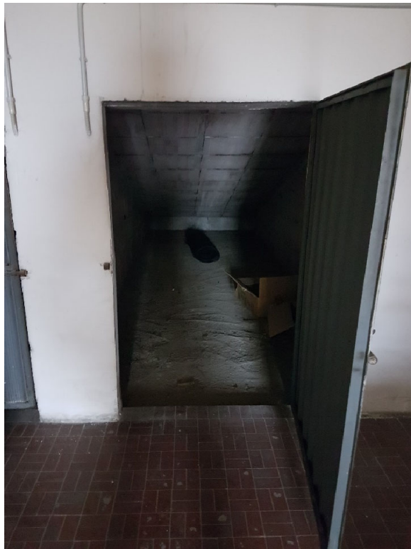
VISTA 17B – SOFFITTA, VISTA INTERNA
