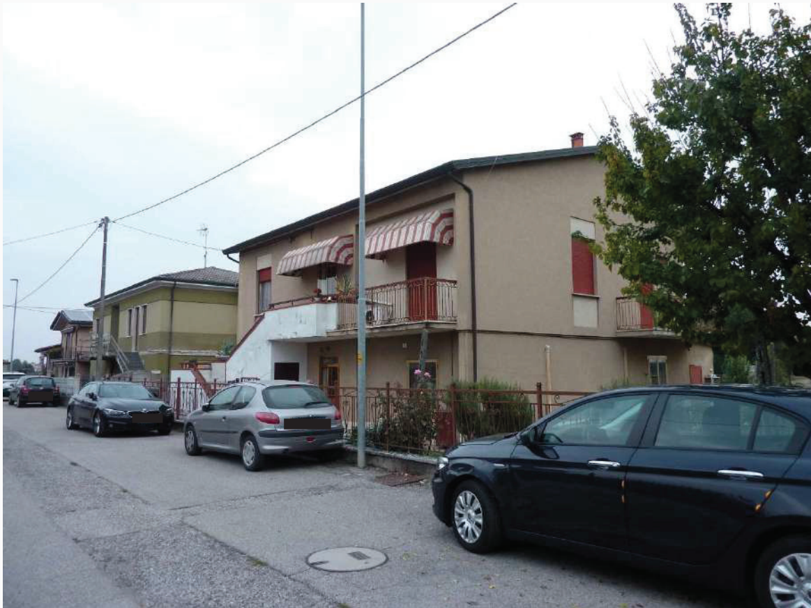
FOTO 3 _ VISTA ANGOLARE DEL FABBRICATO E DELL'AREA ESTERNA COMUNE DA VIA PO – PROSPETTI OVEST E SUD
