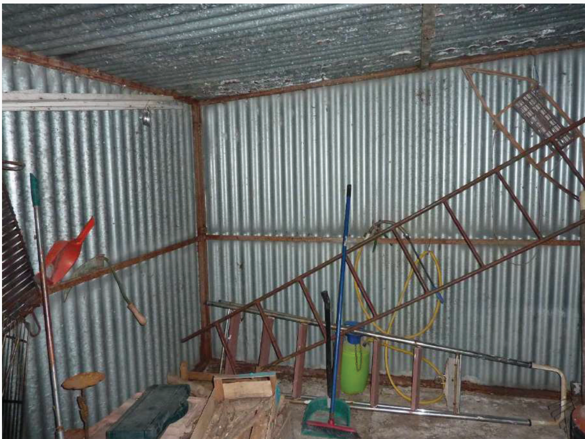
FOTO 16 _ VISTA INTERNA: RIPOSTIGLIO ESTERNO IN LAMIERA SUB 1
