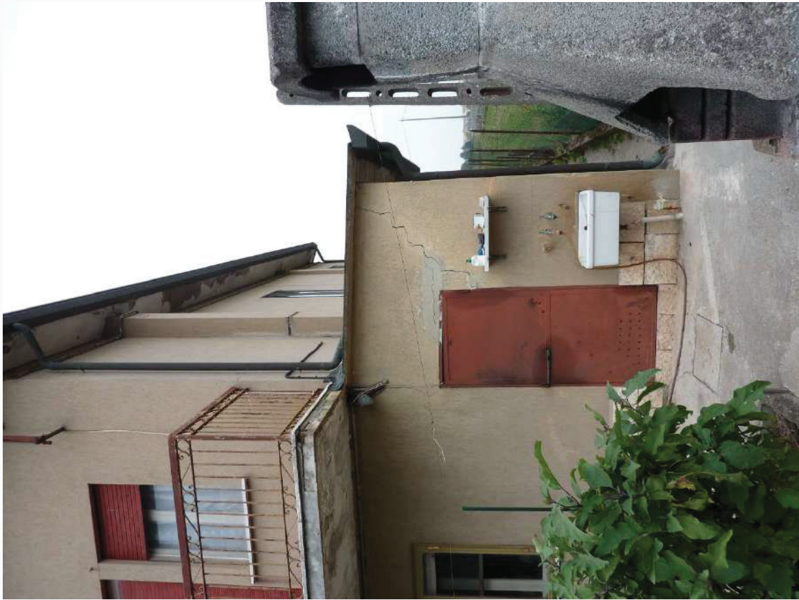
FOTO 11 _ PARTICOLARE ACCESSO CENTRALE TERMICA SUB 1
