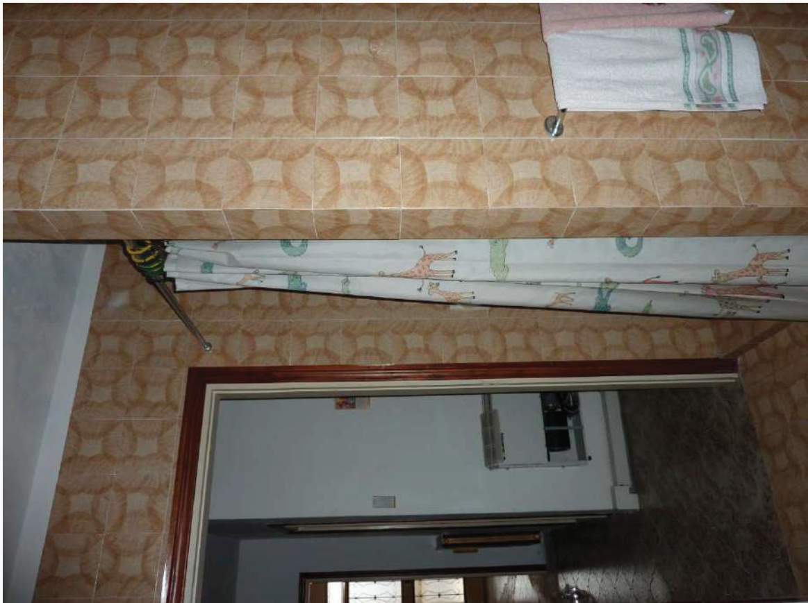
FOTO 24 _ VISTA INTERNA APPARTAMENTO PIANO TERRA SUB 1: BAGNO
