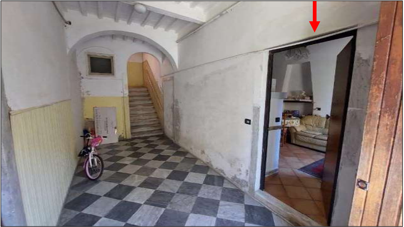
FOTO 26 – atrio vano scale fabbricato (sub. 22 - B.C.N.C.) e porta di accesso all'Immobile 1 oggetto della procedura
