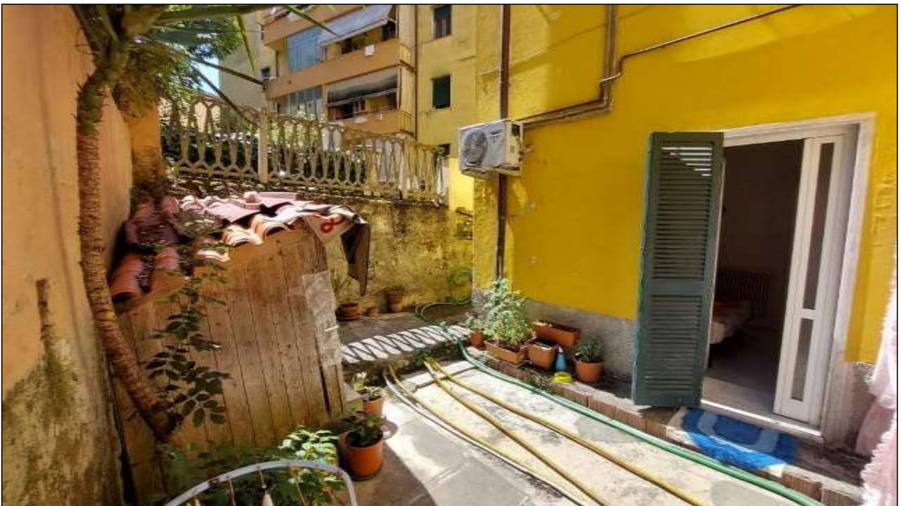
FOTO 23 – corte comune e porta finestra della camera dell'Immobile 1 – LOTTO UNICO
