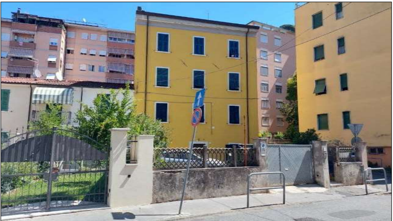
FOTO 2 – prospetto su via Pietro Tacca
