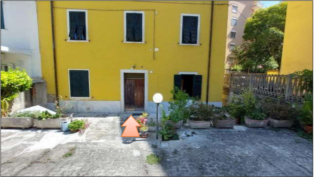
FOTO 12 – area parcheggio e ingresso al fabbricato mapp. 137
