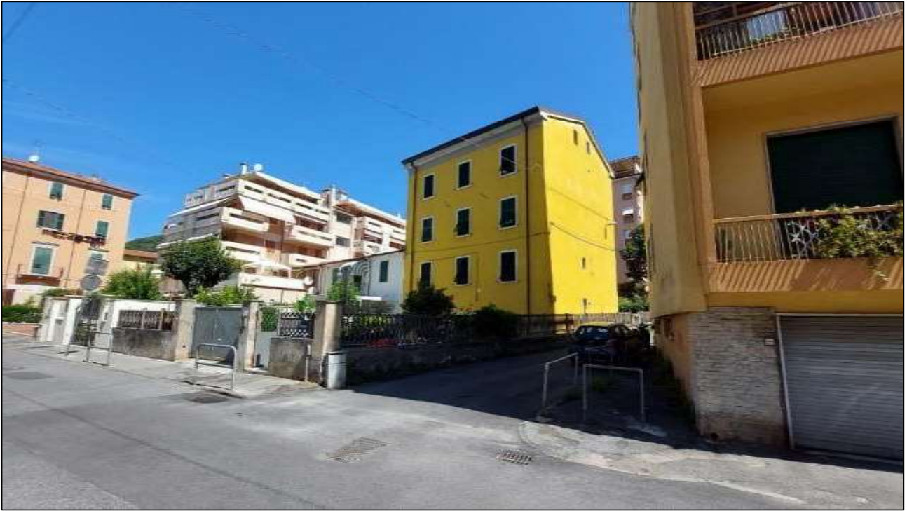
FOTO 3 – prospetto principale e laterale
