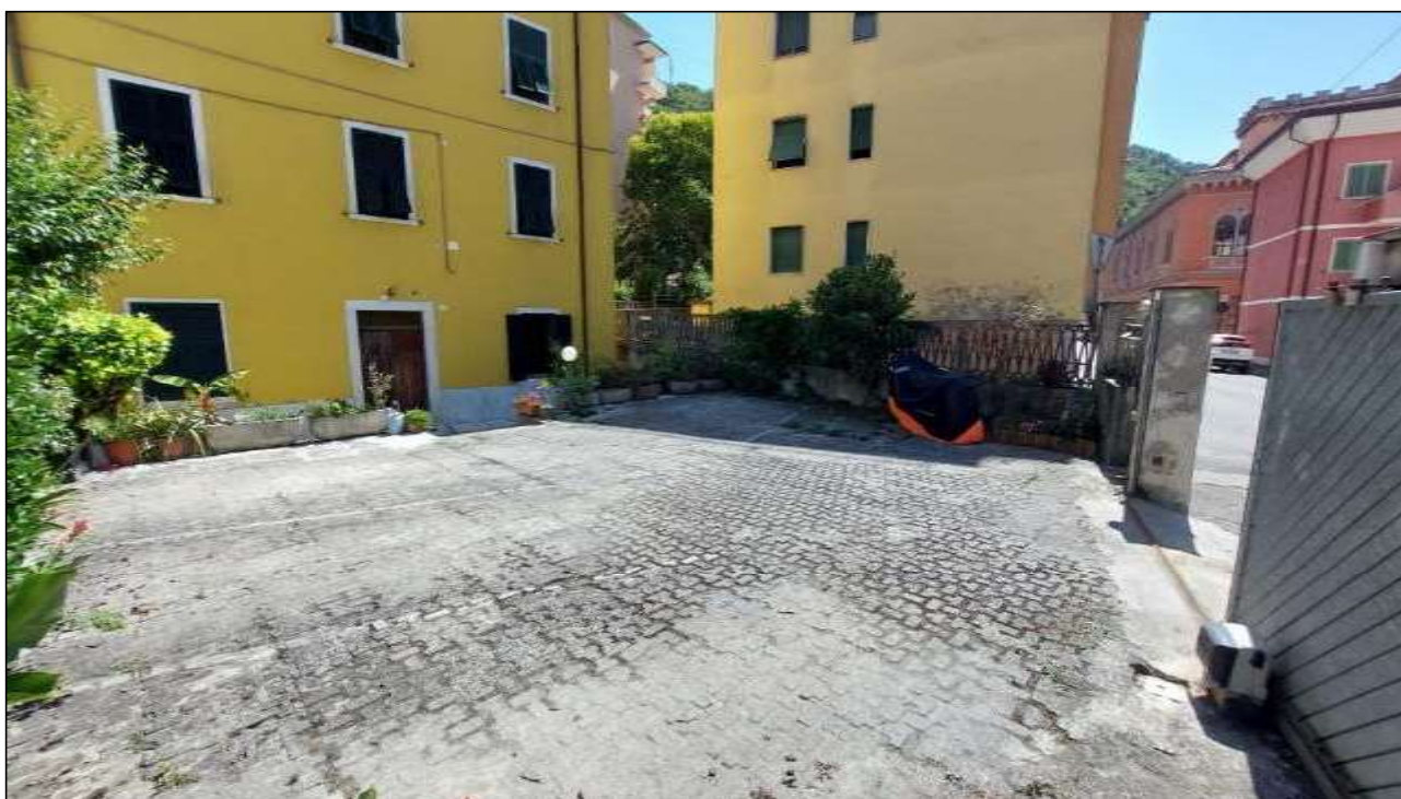
FOTO 7 – area parcheggio antistante il fabbricato - mappali 132, 133 e 134 altra proprietà, non oggetto della procedura
