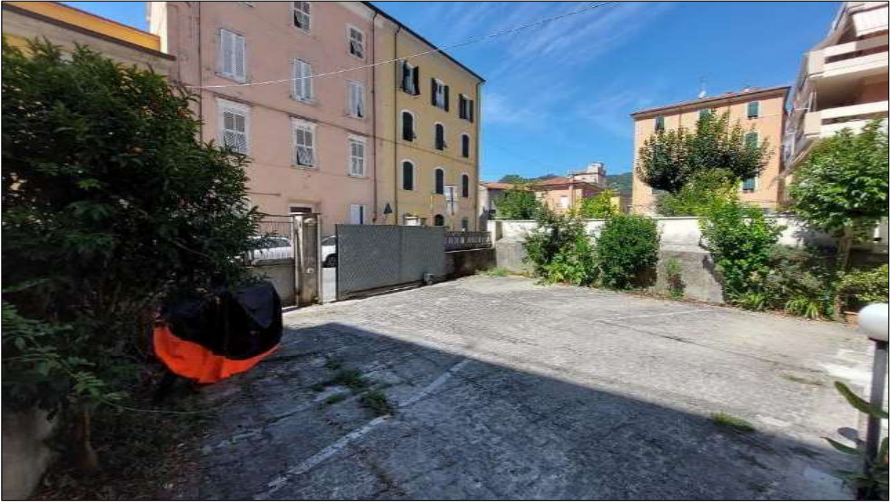
FOTO 8 – area parcheggio antistante il fabbricato - mappali 132, 133 e 134 altra proprietà, non oggetto della procedura
