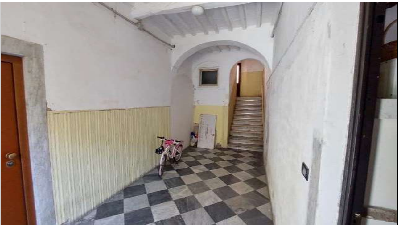
FOTO 27 – atrio vano scale fabbricato (sub. 22 - B.C.N.C.)
