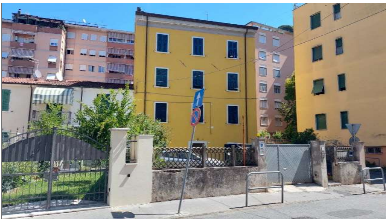
FOTO 2 – prospetto su via Pietro Tacca
