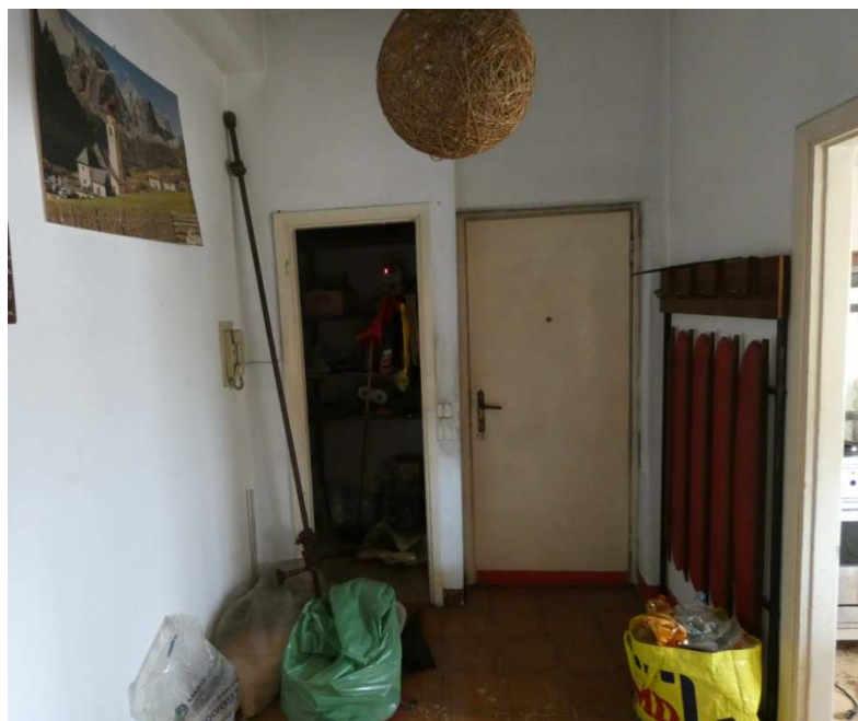
10- dettaglio del disimpegno dell'appartamento
