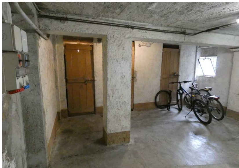
17-disimpegno comune di accesso alla cantina
