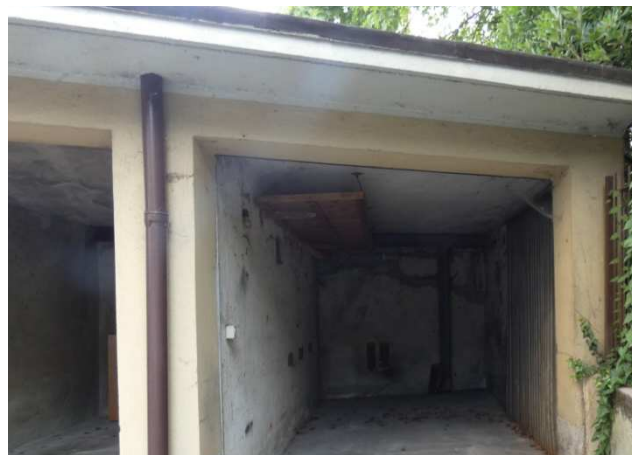
23-dettaglio interno box di****Omissis*****.
