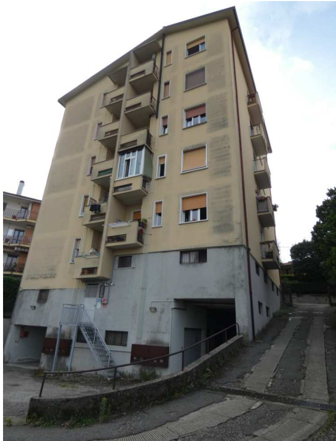
5-Dettaglio della facciata secondaria verso la ferrovia
