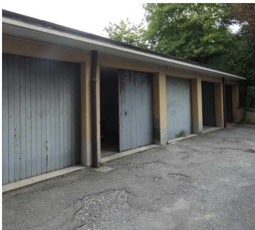
22-corsello condominiale di distribuzione dei boxes
