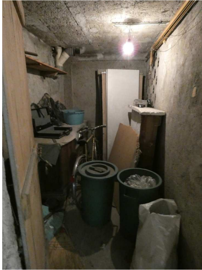
18-dettaglio dell'interno del locale cantina
