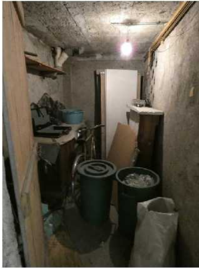
16-dettaglio dell'interno del locale cantina
