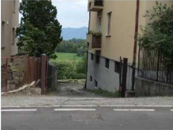
17- carraio di accesso ai box. da Via del Castano
