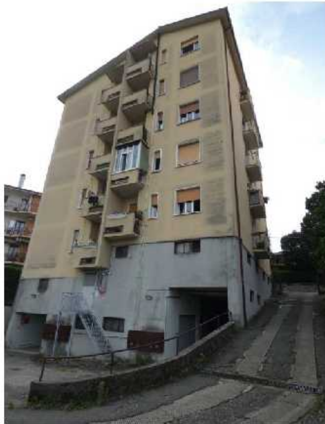
5-Dettaglio della facciata secondaria verso la ferrovia
