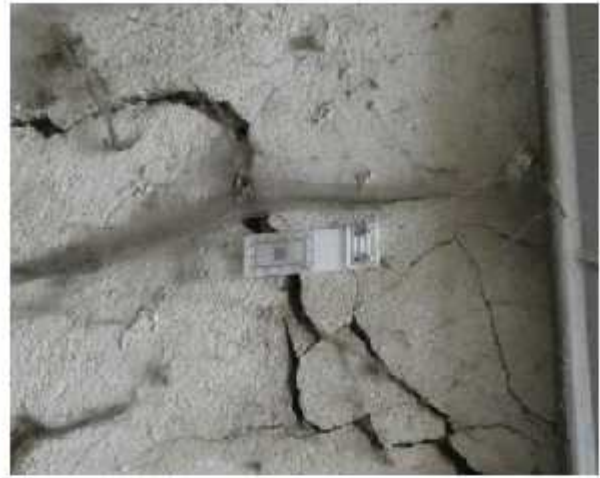
24-dettaglio di alcuni "vetrini per crepe/fessurimetri" all' interno box di ****Omissis****.
