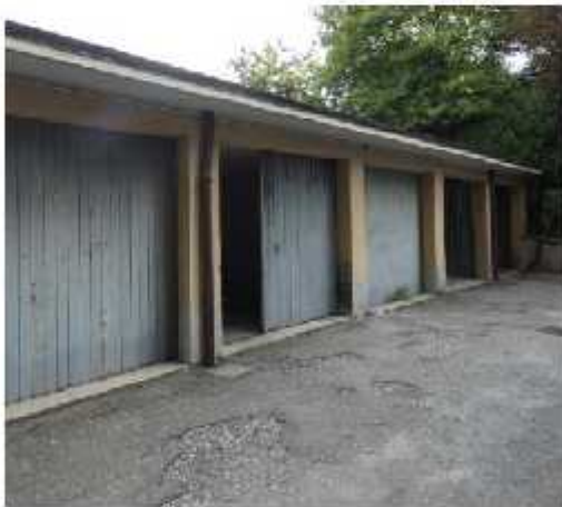
19-corsello condominiale di distribuzione dei boxes
