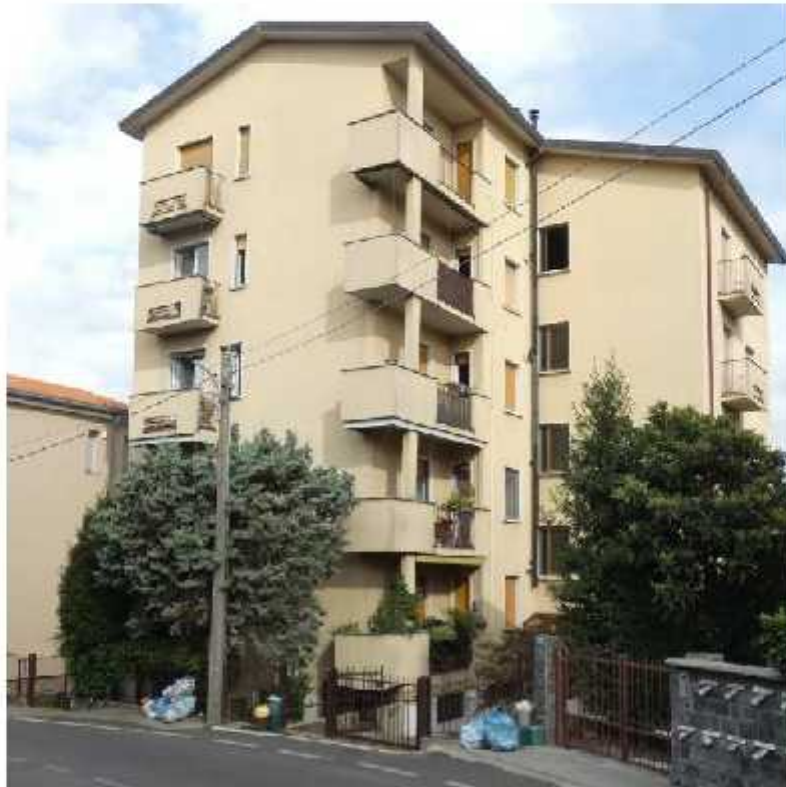
4-Dettaglio della facciata principale lungo Via del Castano
