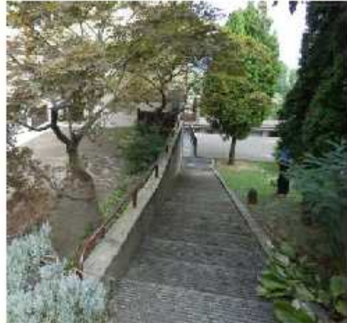
18- scala condominiale di accesso ai box.
