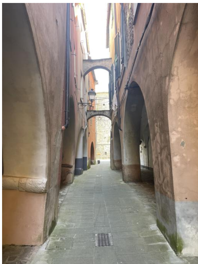
Foto 6— vista del porticato di Via dei Portici da nord in corrispondenza dell'edificio civ.10
