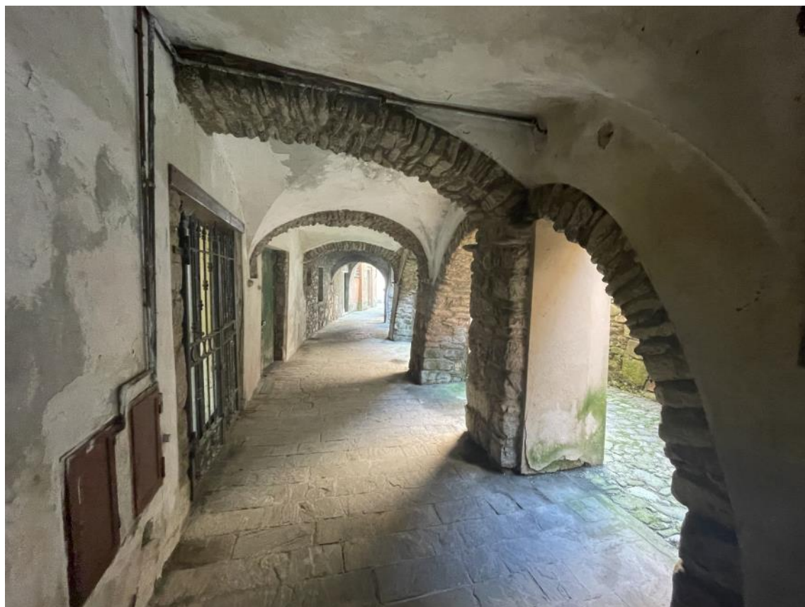
Foto 23— Vista del porticato di Via dei Portici antistante il locale magazzino
