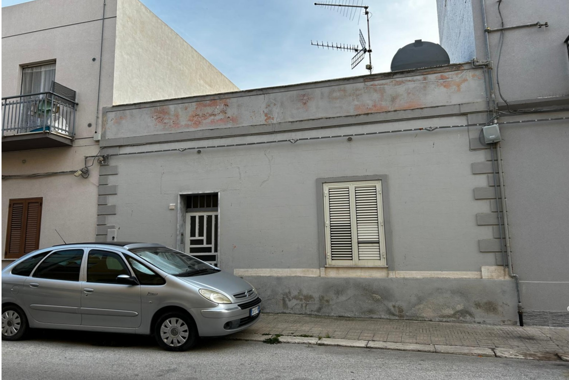
Ingresso fabbricato piano terra ERICE _ Via Battipaglia n. 23
