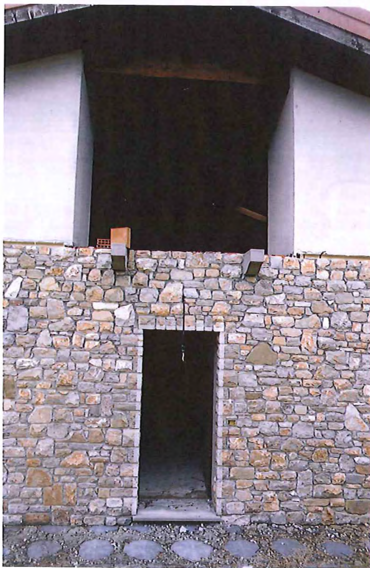
Facciata vista lato Est
