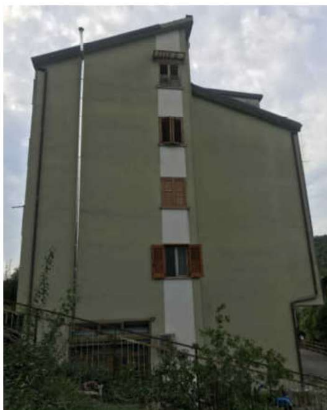
FOTO PROSPETTO NORD
