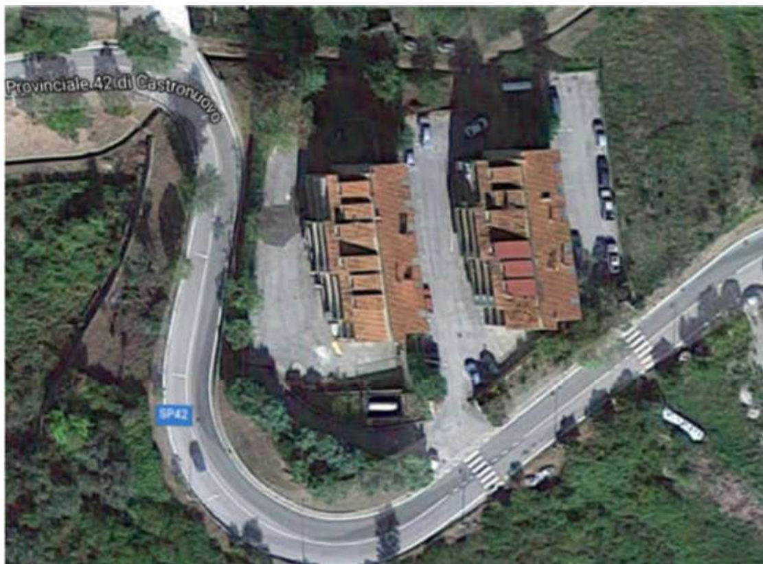
Ortofoto Area di intervento
