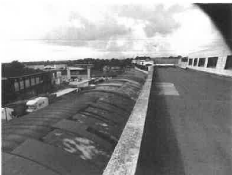
Foto 21 - solaio di copertura della stecca e del capannone
