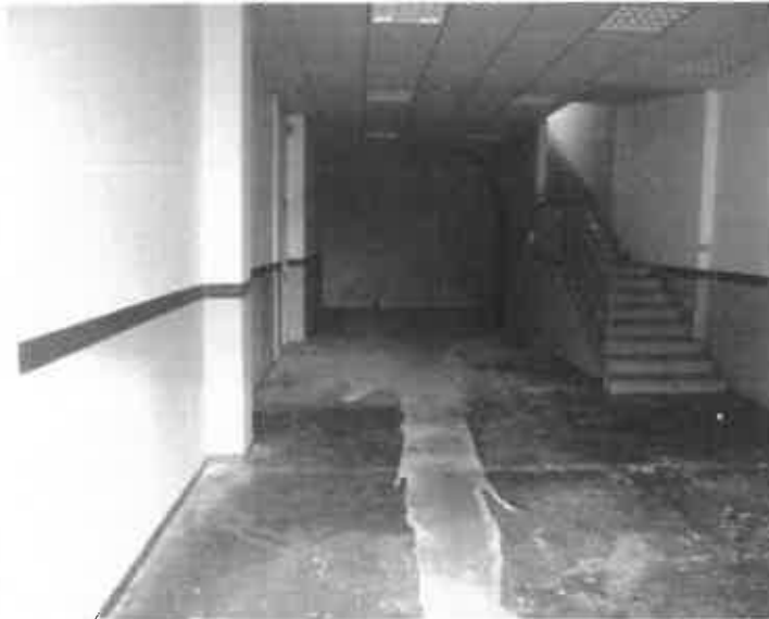
Foto 11 - interno della stecca adiacente al capannone
