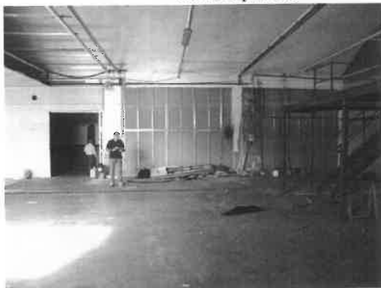
Foto 18 - interno del capannone
