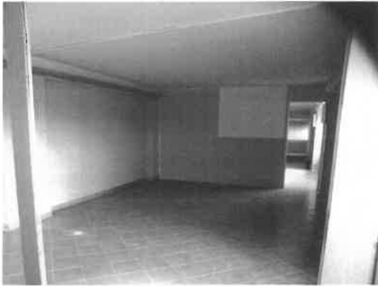
Foto 13 - interno della stecca adiacente al capannone
