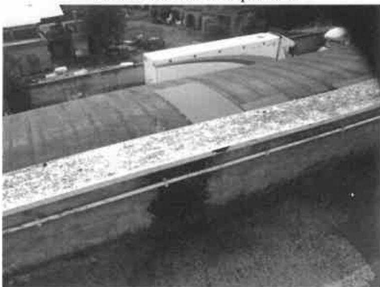
Foto 20 - solaio di copertura della stecca e del capannone
