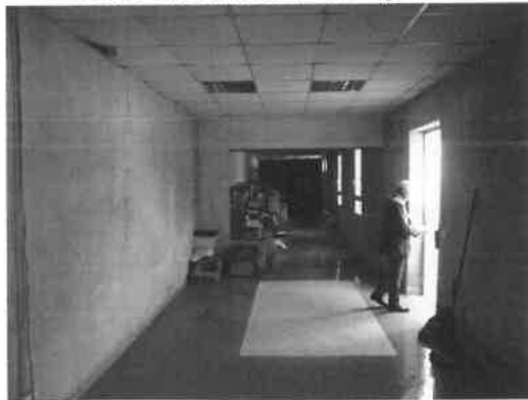
Foto 9 - interno stecca a destinazione magazzino
