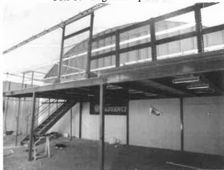
Foto 17 - interno del capannone
