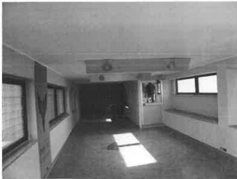
Foto 12 - interno della stecca adiacente al capannone
