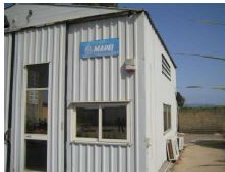
Foto 2, Vista esterna fabbricato
