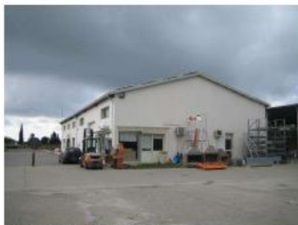
Foto 2, Fabbricato H vista laterale
