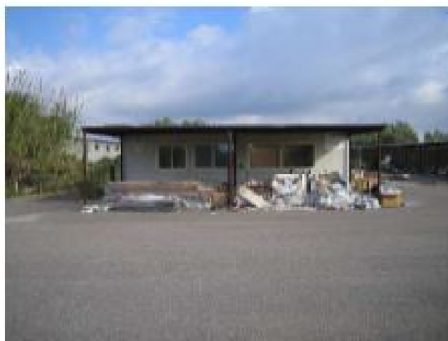
Foto 4, Vista tettoia laterale
