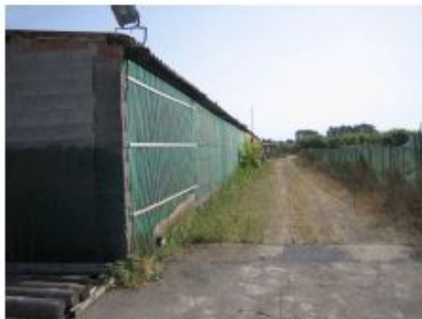
Foto 12, Tettoia vista posteriore
