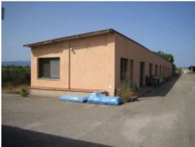
Foto 1, Vista esterna dell'edificio fabbricato B
