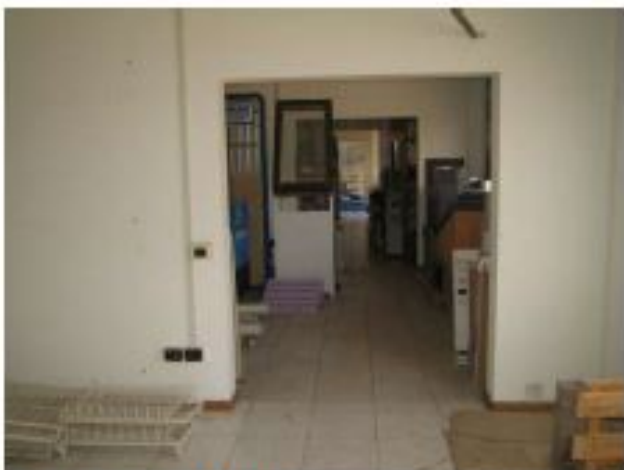
Foto 5, Vista interna dei locali
