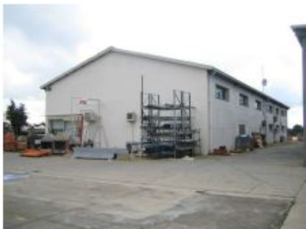
Foto 3, Fabbricato H vista posteriore
