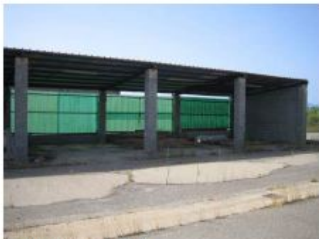
Foto 11, Tettoia vista frontale
