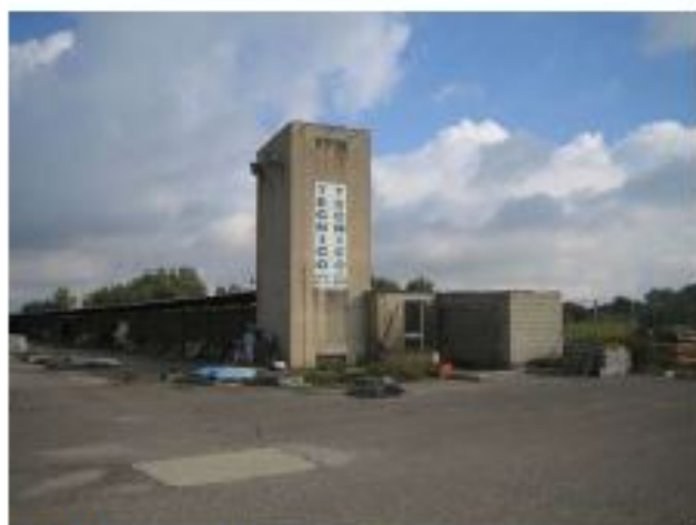
Foto 1, Vista esterna Cabina elettrica
