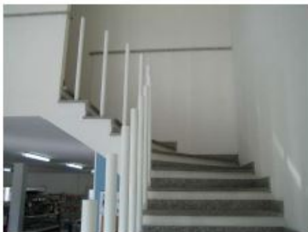
Foto 1, Scale di accesso al Piano primo
