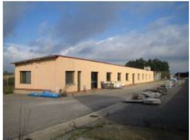
Foto 2, Vista esterna fabbricato
