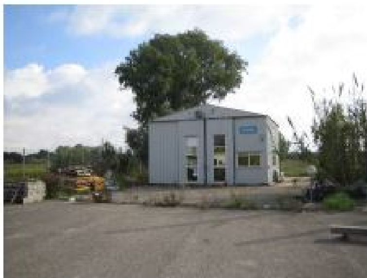
Foto 1, Vista esterna fabbricato
