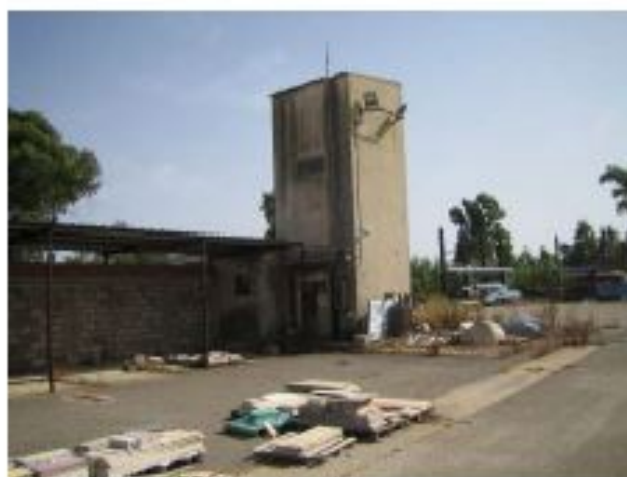
Foto 3, Vista esterna Cabina elettrica
