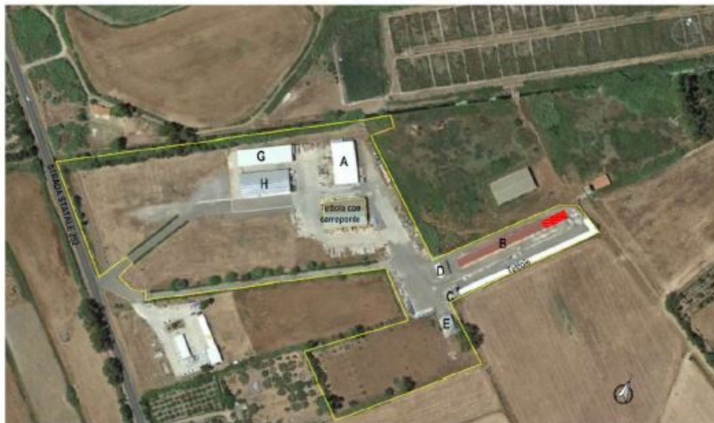
Foto 2, Vista aerea INDIVIDUAZIONE DEI FABBRICATI
