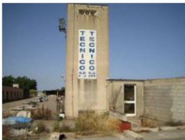
Foto 2, Vista esterna Cabina elettrica
