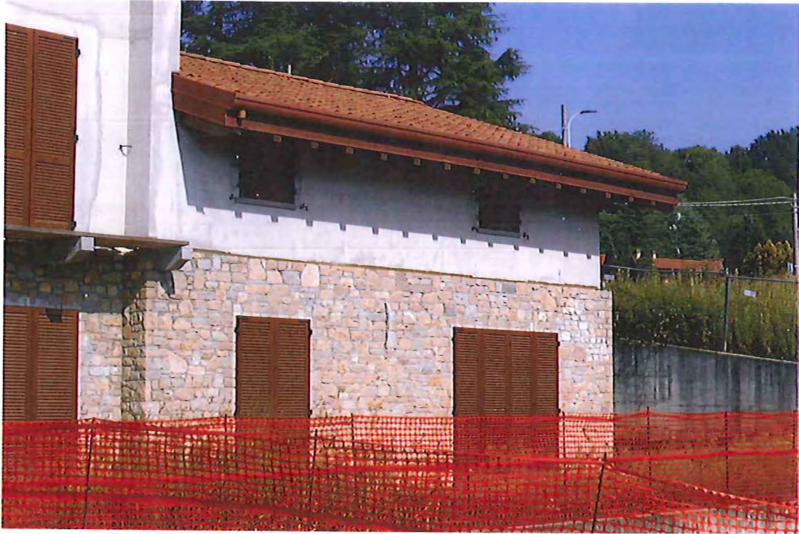
Facciata vista lato Sud
