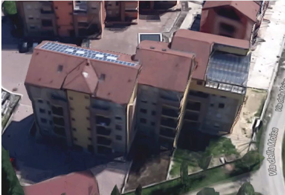
Vista aerea da est presa da Google
