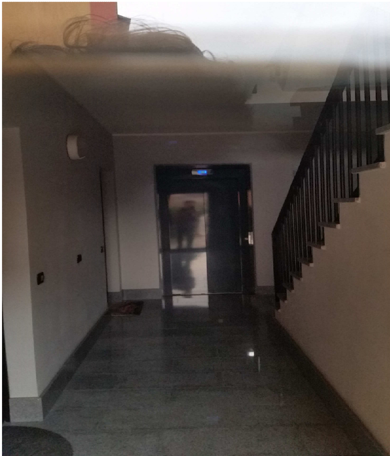
Pianerottolo piano terra
