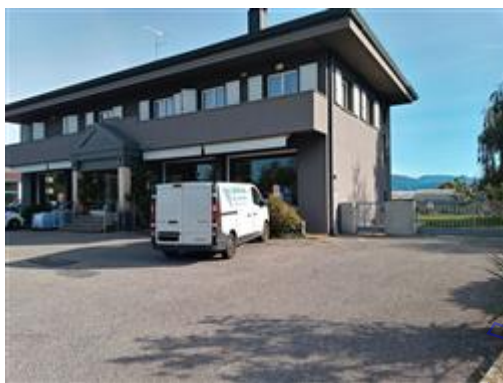
Area di parcheggio (fronte strada)
