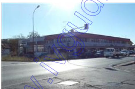
Contesto urbano adiacente: incrocio Via Roma (tratto urbano della S.S. 13 Pontebbana) - Via San Giorgio
