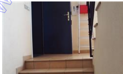
Vano scala lato sud (particolare)
