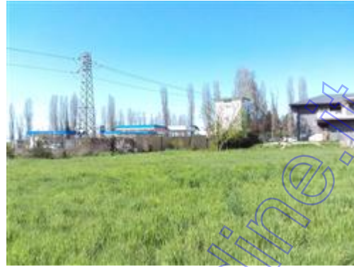
Vista verso sud-ovest, con parziale interessamento passaggio linea elettrica aerea BT
