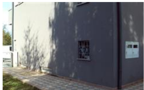
Fronte sud (particolare)
