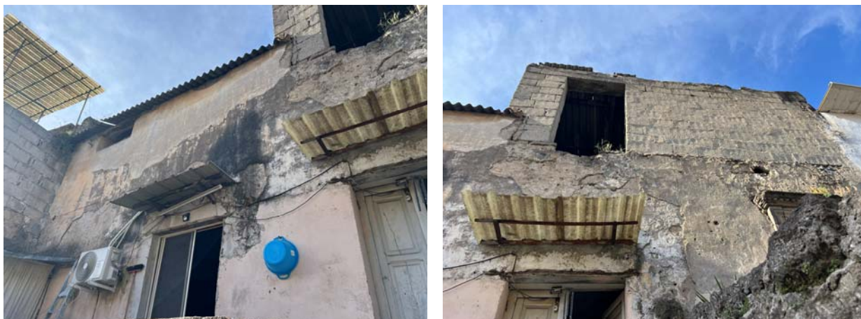
Vista dei due ambienti sottotetto, privi di accesso
