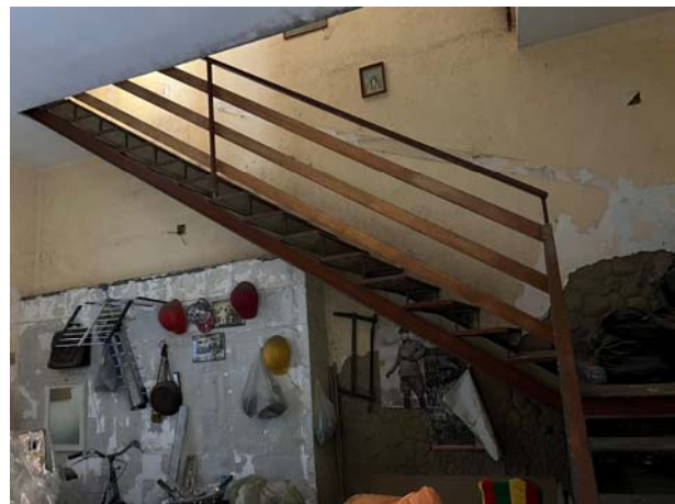
Dettagli della scala metallica interna che collega il vano terraneo a quello del piano primo posto sulla destra
