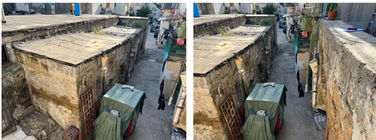
Vista dei vani terranei posti nel cortile, a margine della scala esterna di accesso ai vani principali.
