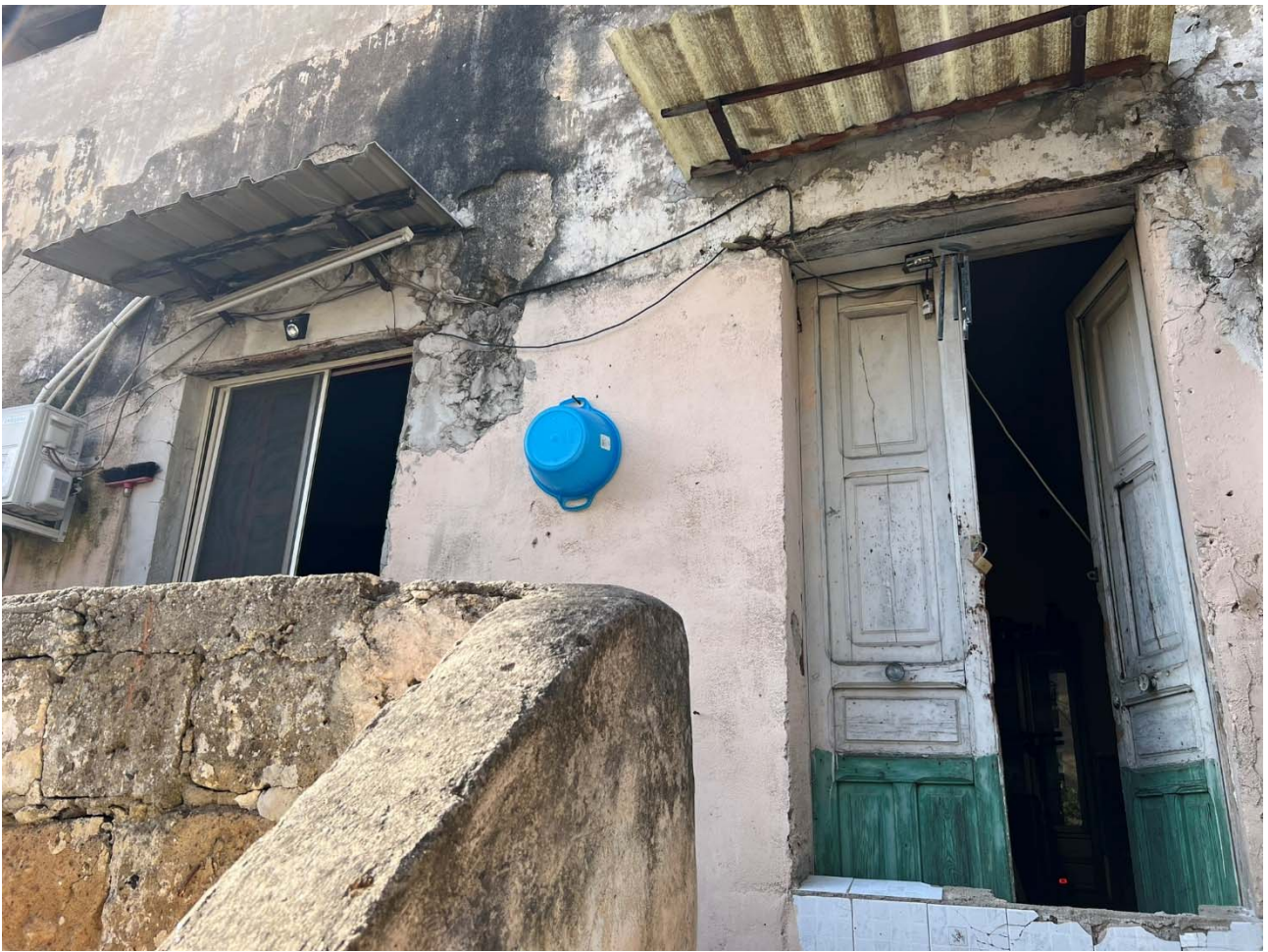
Foto 9 – Vista dell'ingresso ai vani del piano primo
