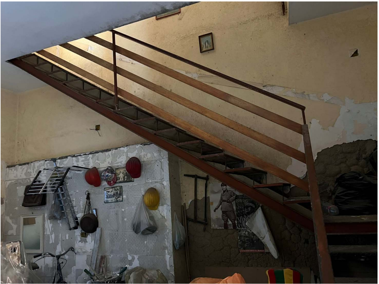
Foto 17 – Vista della scala che collega la camera di destra al sottostante terraneo
