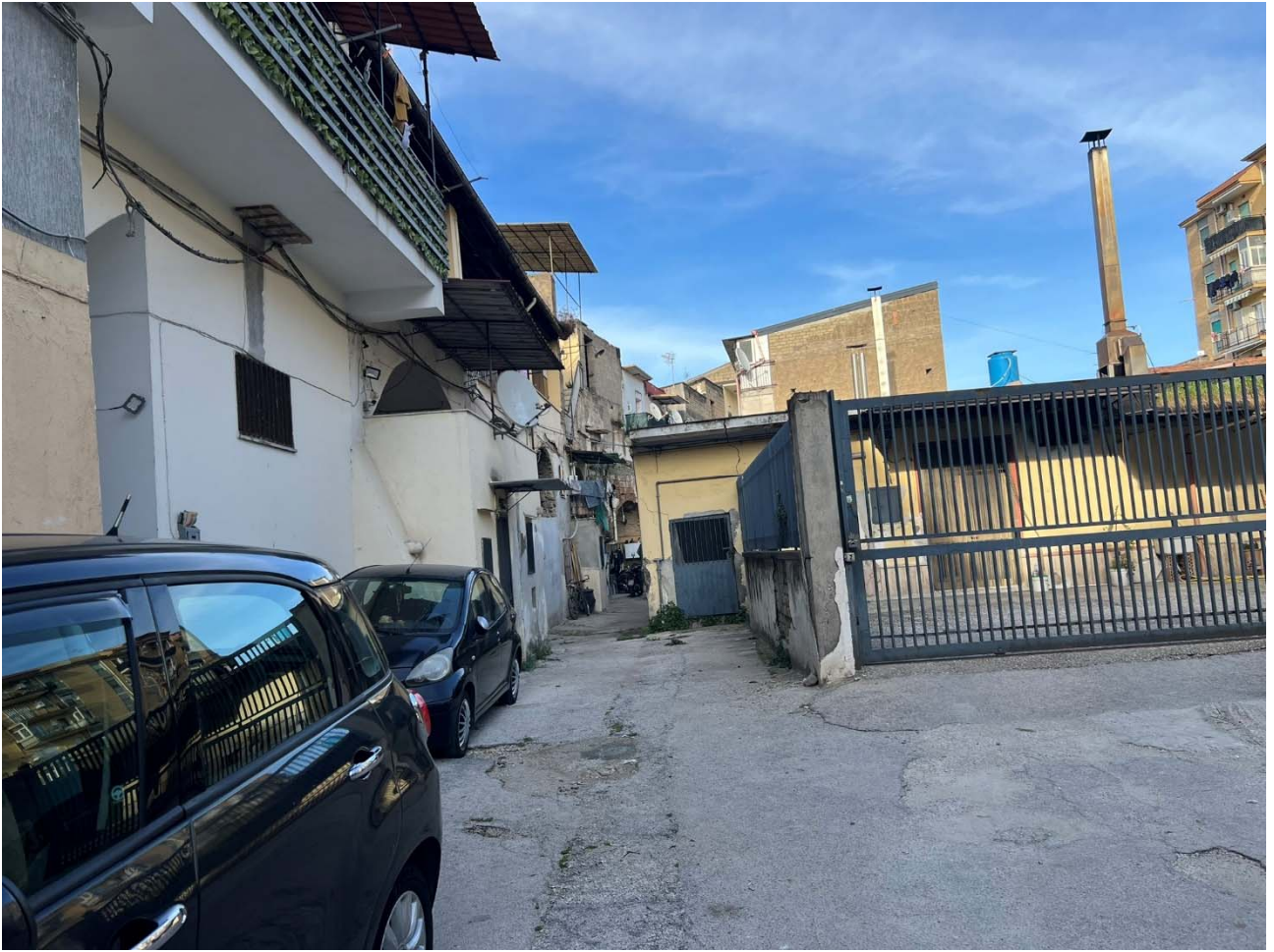
Foto 3 – Vista dell'area cortilizia del complesso (da cui traggono accesso tutti i beni del compendio staggito)
