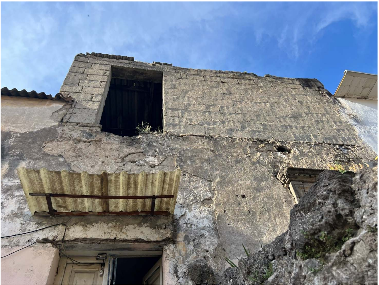
Foto 11 – Vista del sottotetto posto sul vano di destra (ampliato)
