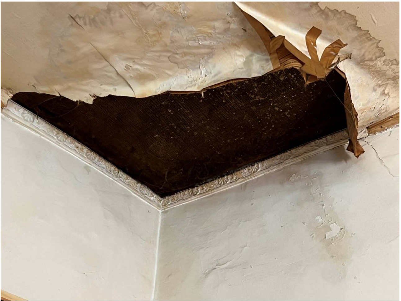
Foto 25 – Dettaglio del controsoffitto della camera di sinistra
