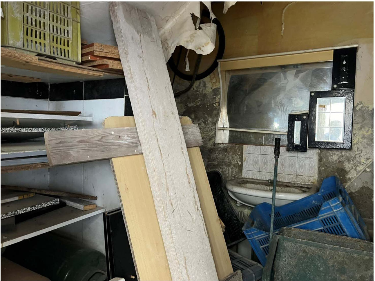
Foto 7 – Particolare interno di uno dei due locali terranei
