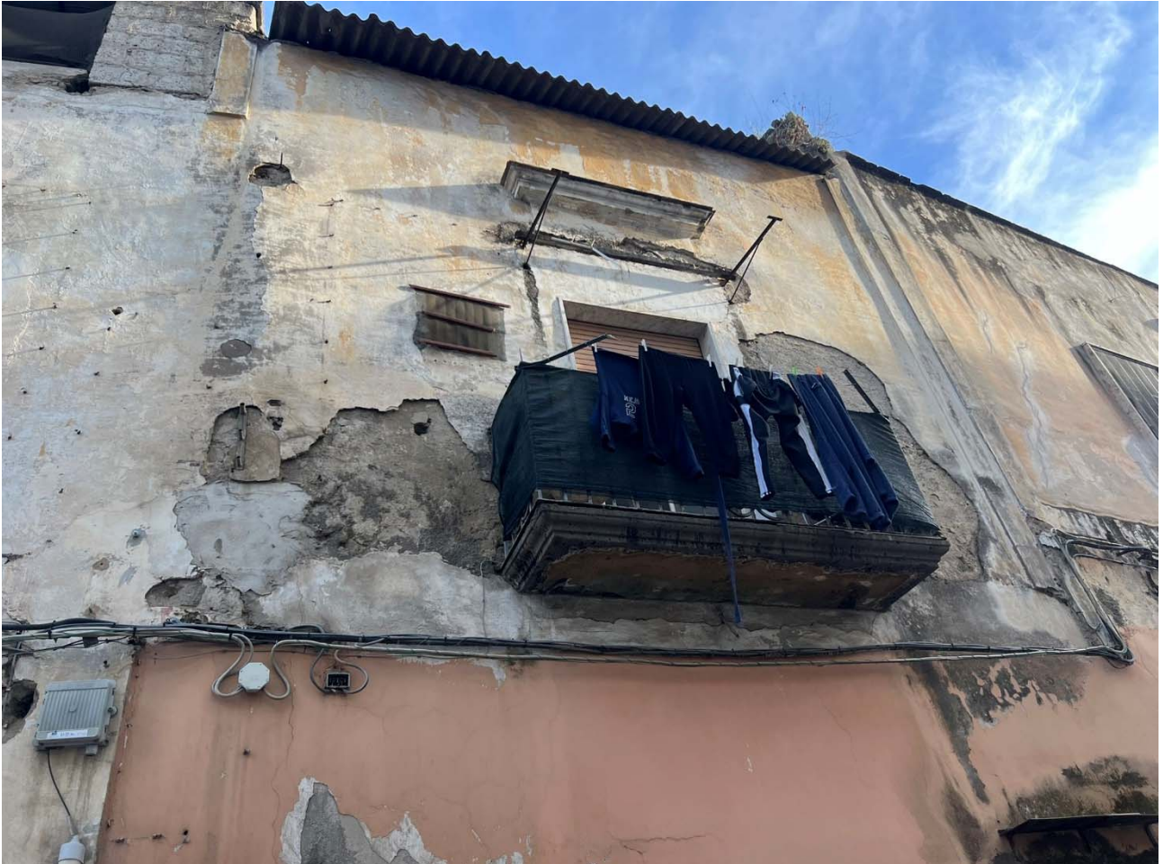
Foto 26 – Vista esterna del balcone della camera di sinistra del piano primo
