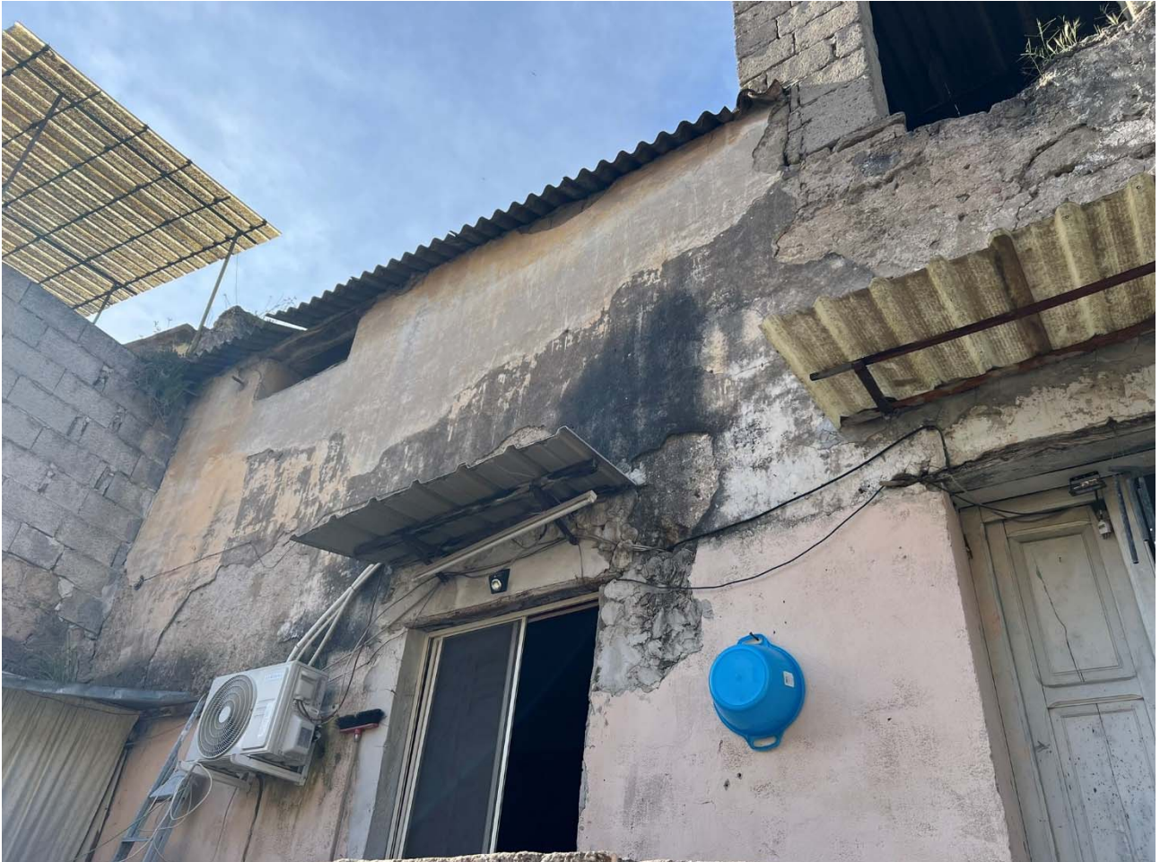
Foto 10 – Vista del sottotetto posto sul vano di sinistra
