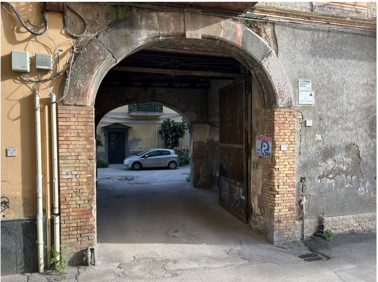
Foto 2 – Vista del portone di ingresso al complesso edilizio di via Filomarino 2
