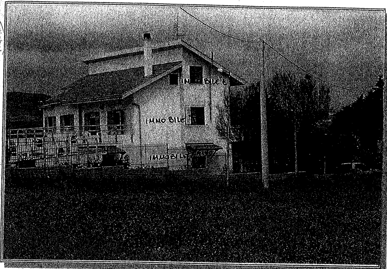
FOTO N° 1 - STATO DEI LUOGHI - COMUNE DI POTENZA FOG. 15 - PARTICELLE N° 1201/2 - 1201/3 - 1201/4 - IMMOBILI C - D - E -
