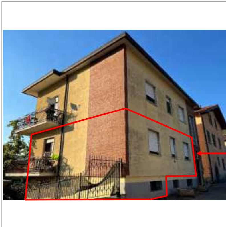
- LOTTO 1 - vista fabbricato da via Bondi -
