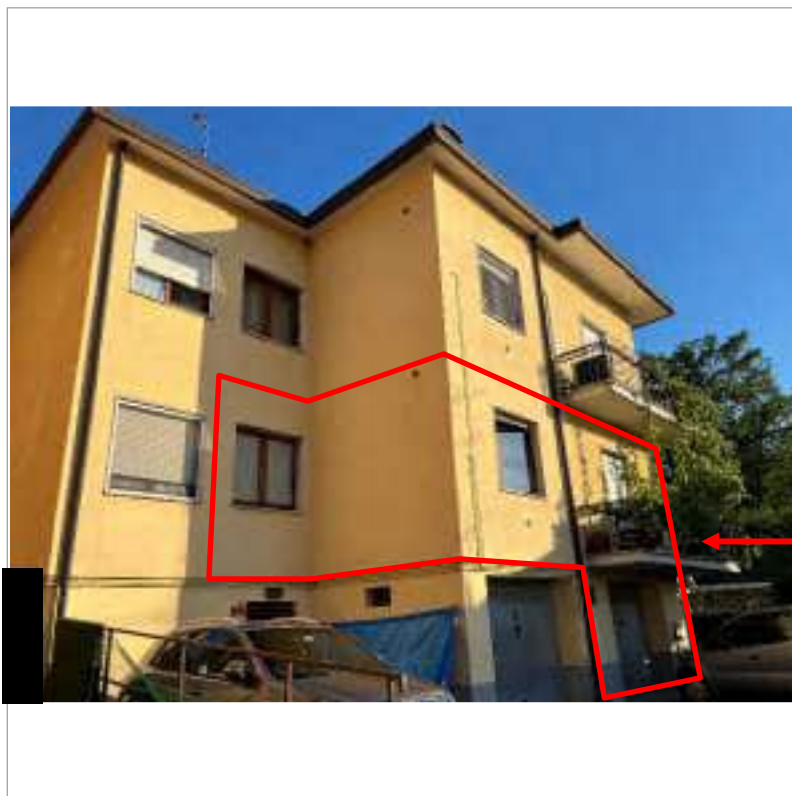
- LOTTO 1 - vista fabbricato da cortile interno -
