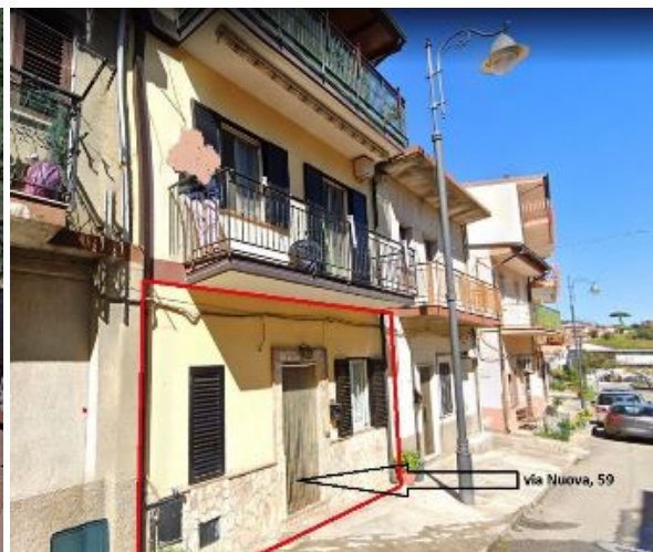
Prospetto principale ed ingresso
