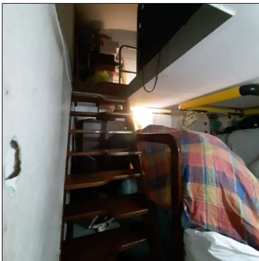
Camera con scala accesso area soppalcata
