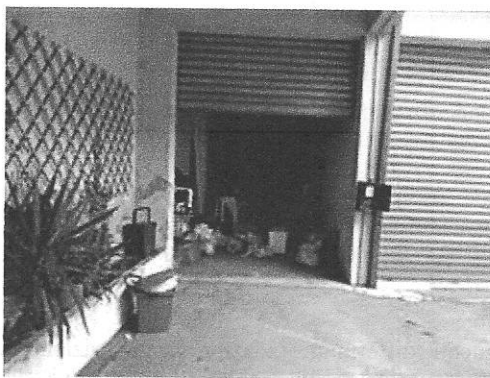
Ingresso box piano terra
