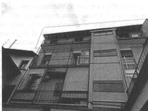
Vista dal cortile interno appartamento
