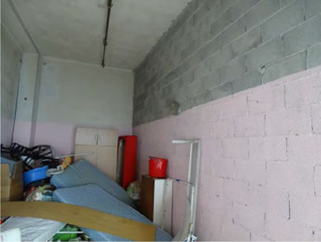
Vista Interna box
