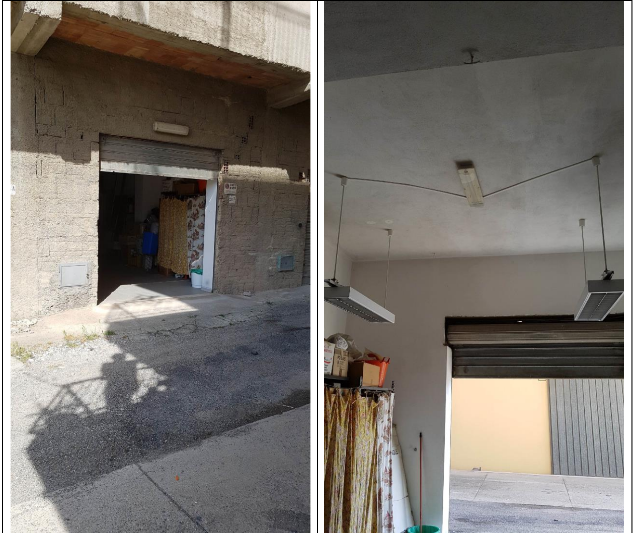
Foto NN.15,16: Ingresso Locale magazzino
