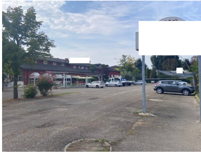
FOTO 1: FRONTE PRINCIPALE VERSO VIA CANALETTO
