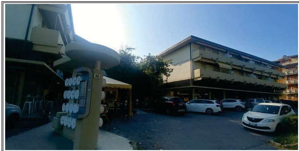
Foto n. 2 – Vista del condominio – Angolo NORD
