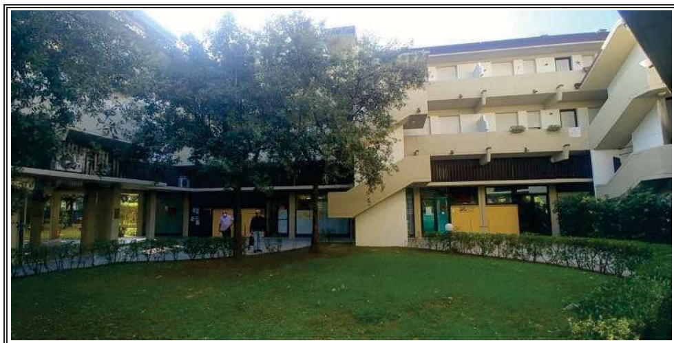
Foto n. 3 – Vista del condominio – Interno della semicorte
