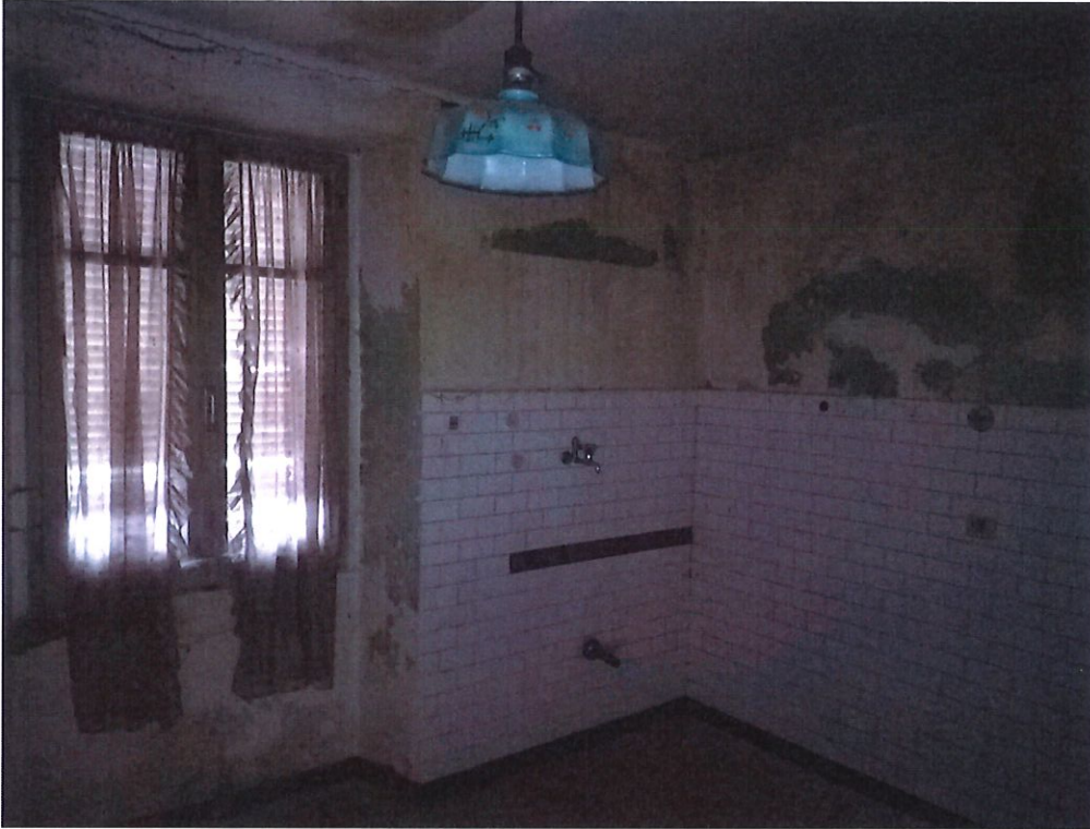
FOTO 3 - PIANO TERRA – vista interna locale
