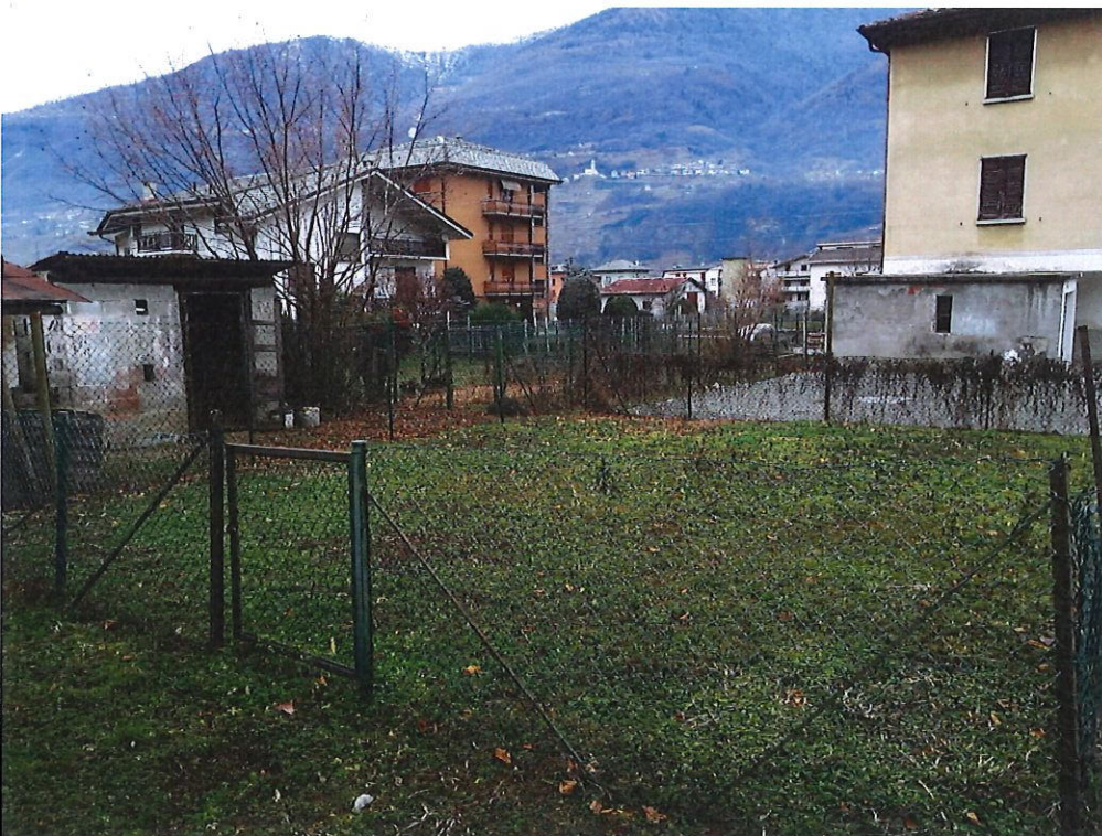
FOTO 7 - PIANO TERRA – vista esterna terreno alla particella 478
