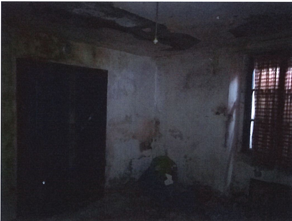
FOTO 4 - PIANO TERRA – vista interna locale
