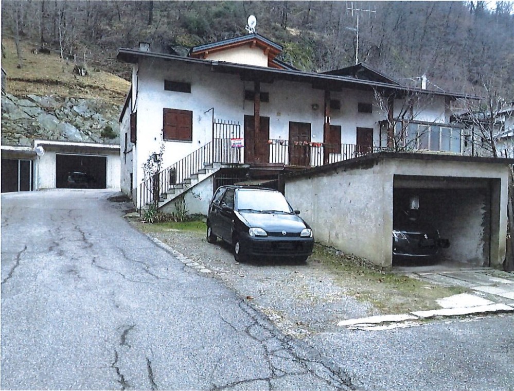
FOTO 8 - PIANO TERRA – vista esterna terreno alla particella 584
