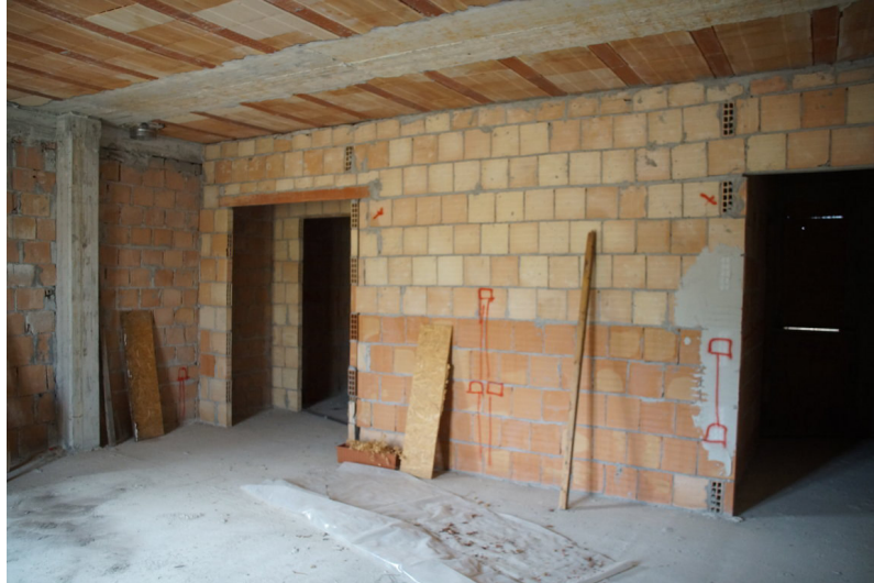
Foto n°19: particolare del bagno con antibagno sulla sinistra e del disimpegno sulla destra.
