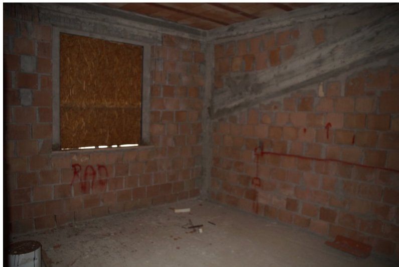
Foto n°20: particolare della camera da letto con affaccio sulla scala esterna posta lungo il lato Ovest.
