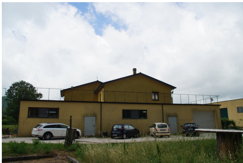
Foto n°4: vista lato Est del fabbricato.
