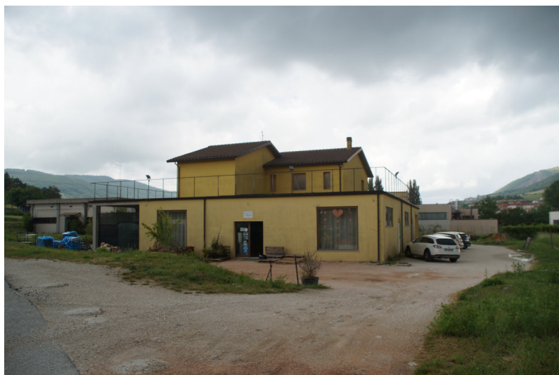
Foto n°1: vista lato Sud del fabbricato che insiste sulla particella n. 2061 del foglio n. 47 di Scheggia e Pascalupo (PG), si noti l'ingresso carrabile che inizialmente insiste sulla particella n. 2062 del foglio n. 47.
