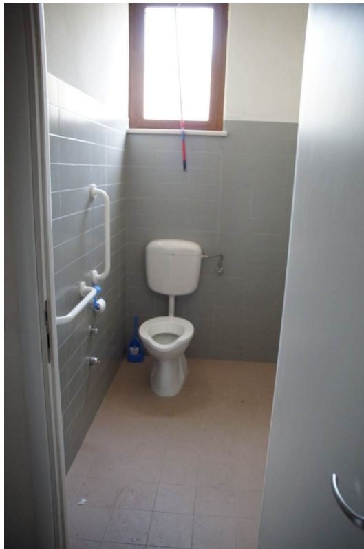
Foto n°12: particolare del bagno attrezzato per persone diversamente abili.
