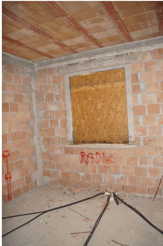
Foto n°23: particolare della terza camera da letto.
