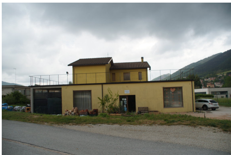
Foto n°2: altro particolare della vista lato Sud, si notino il tetto dell'appartamento a falda doppia ed i canali di gronda con i pluviali discendenti in rame.
