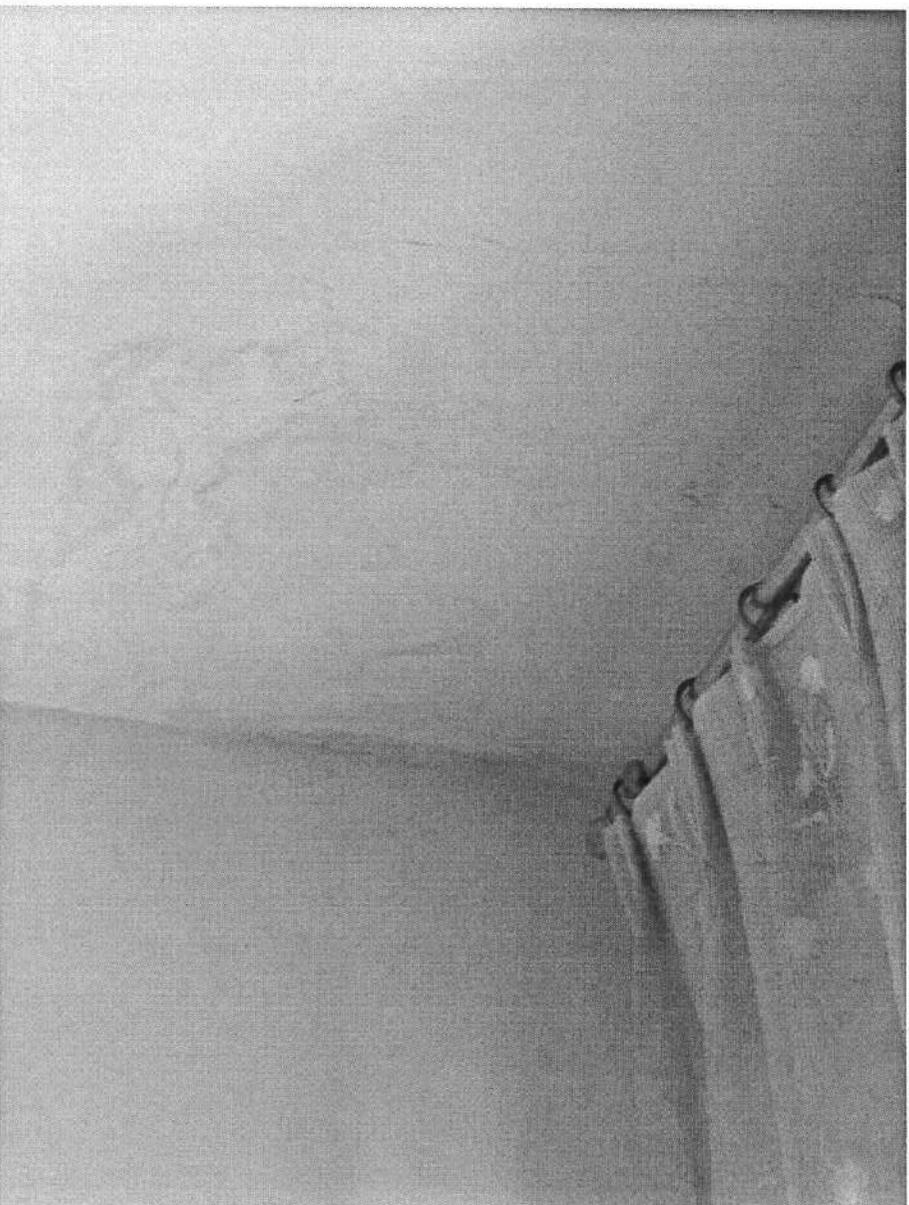
Foto 14 – cucina, particolare infiltrazioni soffitto
