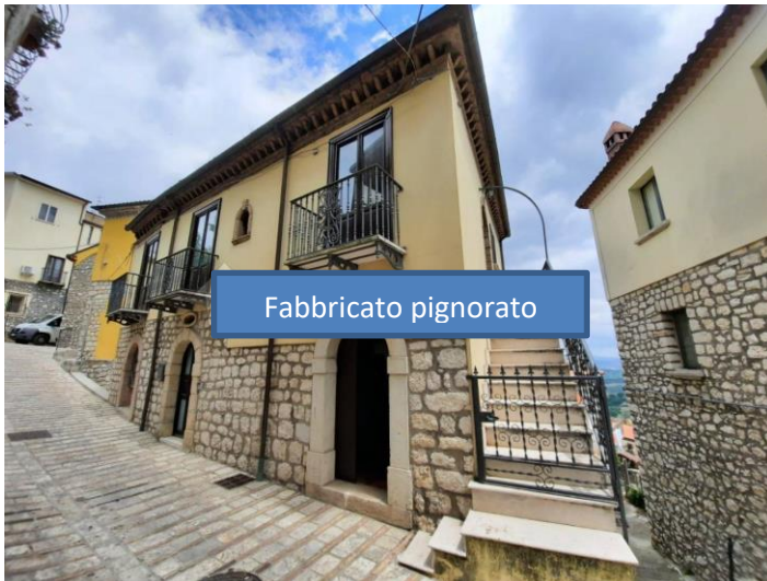
Foto 1 Fabbricato pignorato visto da via Curignale
