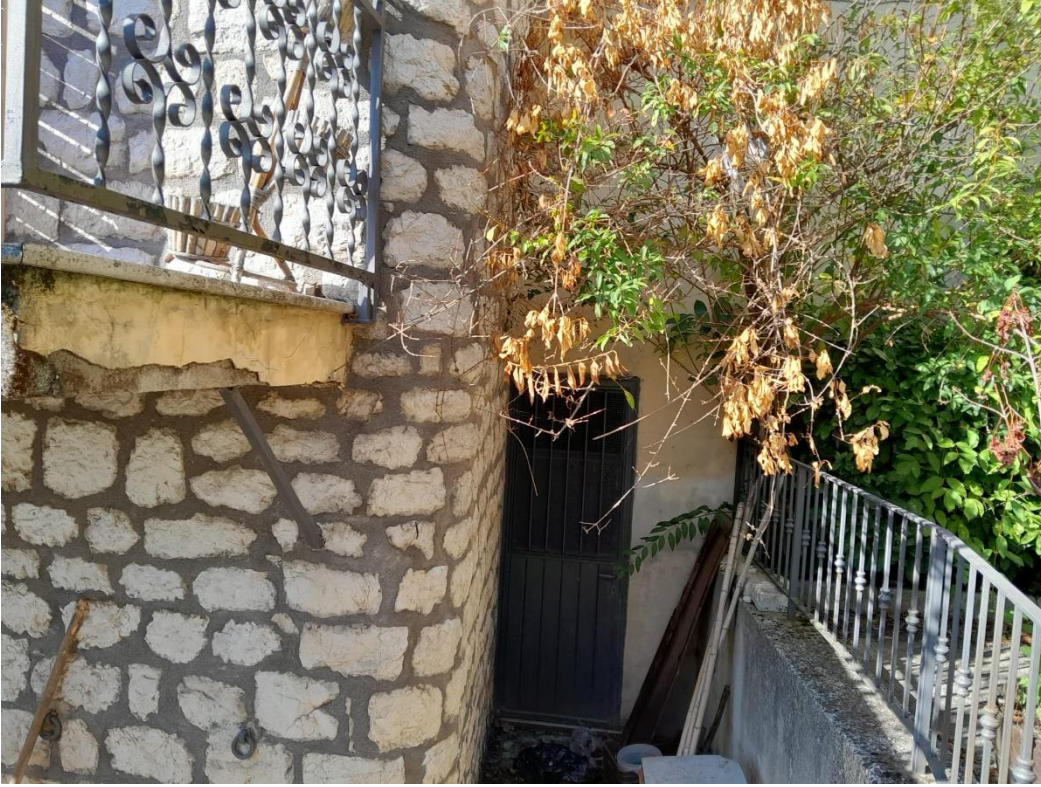
Foto 9 Accesso piano seminterrato
