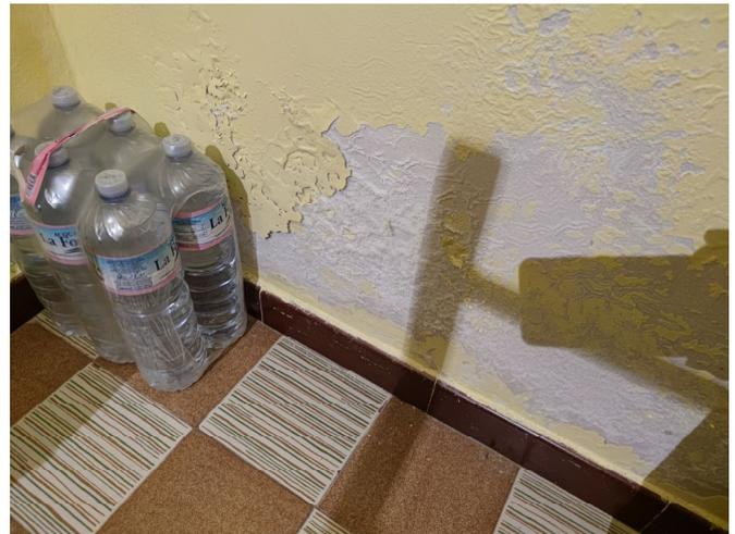
Fig. 21 efflorescenza dovuta all'umidità da risalita del terreno
