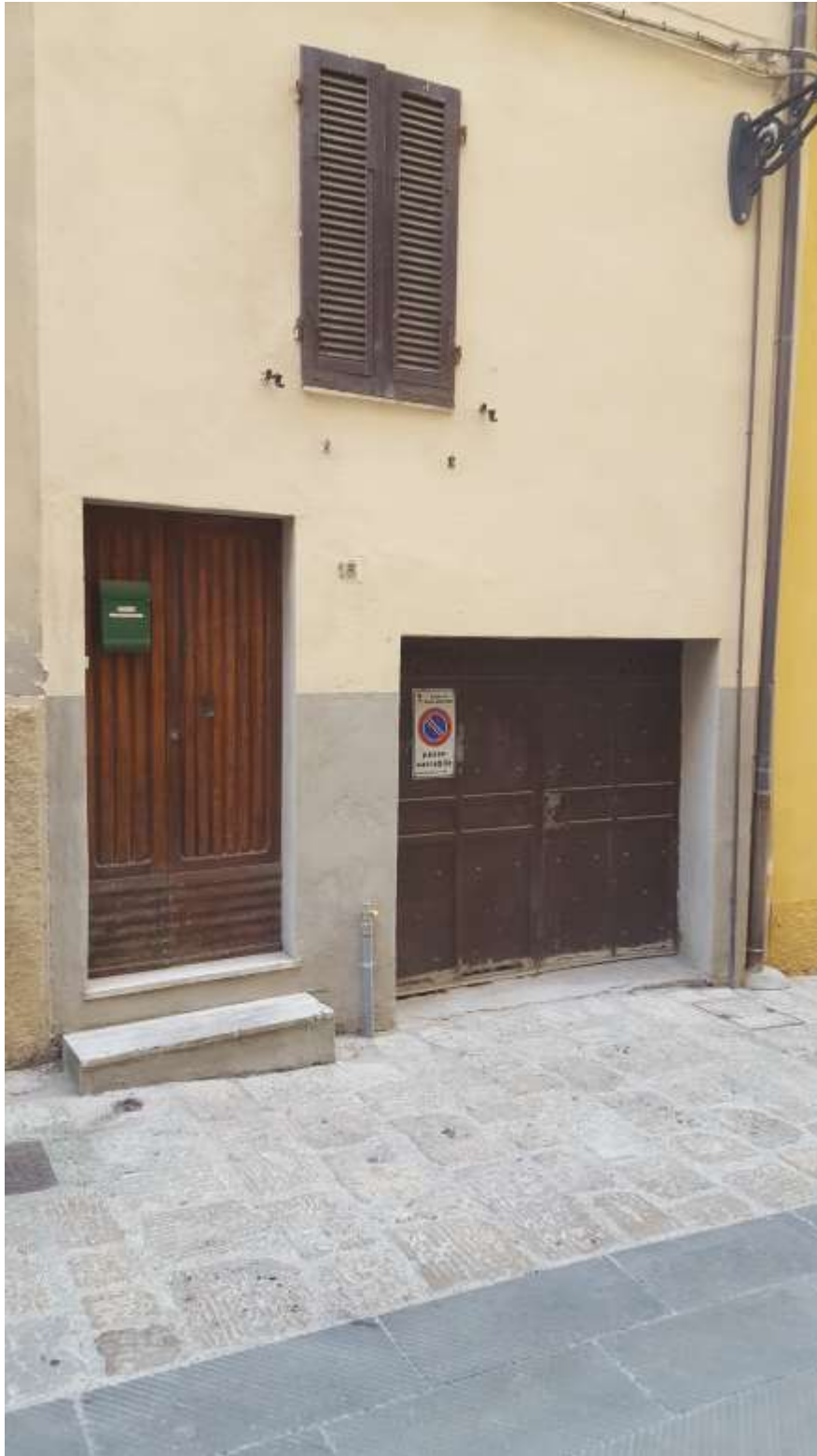
Foto 1 – INGRESSO DALLA VIA
