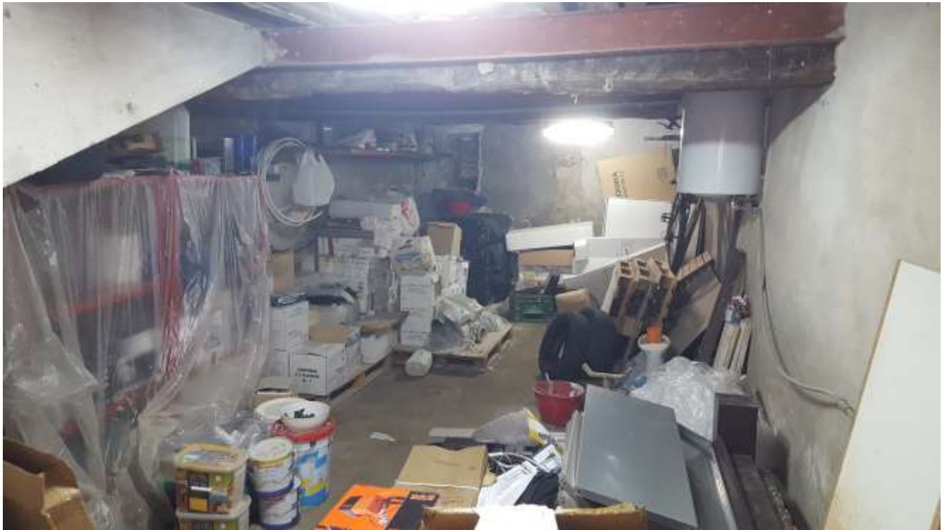
Foto 2- INTERNO DEL MAGAZZINO PIANO TERRA
