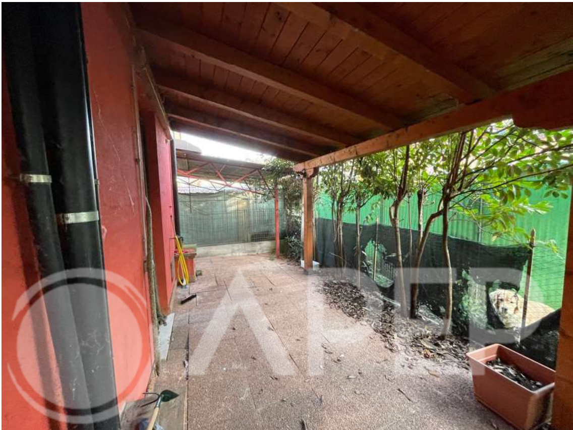
5 - Vista lato est
