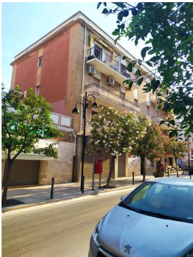
FOTO N. 1 – Prospetto esterno su Viale XXIV Maggio.
