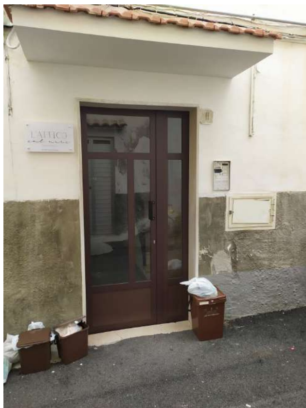
FOTO N. 2 – VISTA DEL PORTONE D'INGRESSO CONDOMINIALE SU VIA CAPPUCCINI.
