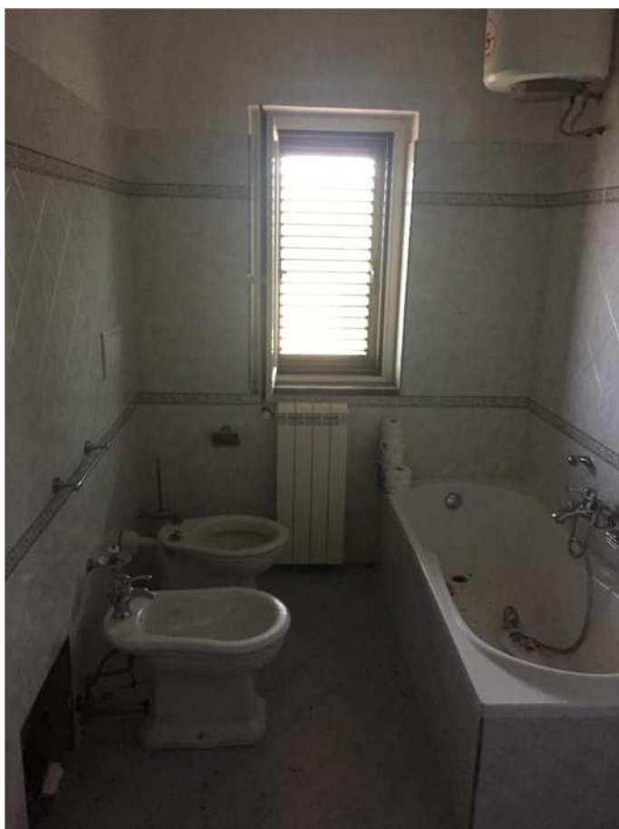
Bagno piano primo
