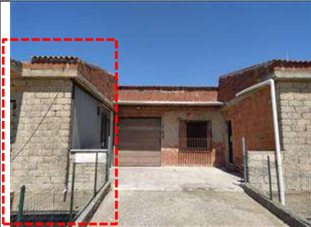
Foto n. 23: Ingresso da rampa lato strada
