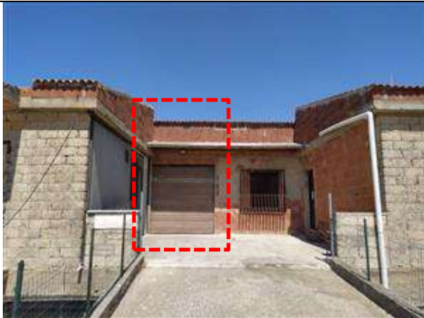
Foto n. 21: Ingresso da rampa lato strada
