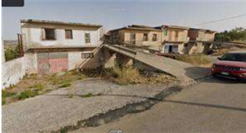
Foto n. 1: Prospetto intero blocco fabbricati
