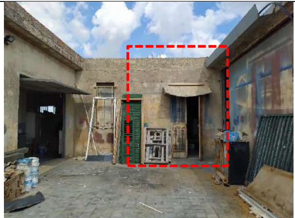
Foto n. 47: Ingresso da rampa lato strada
