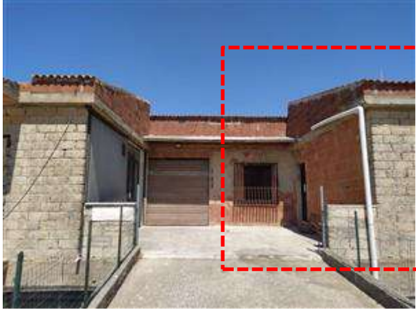
Foto n. 15: Ingresso da rampa lato strada
