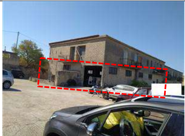
Foto n. 8: Porzione adibita a carrozzeria da dietro
