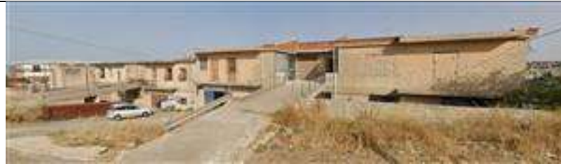
Foto n. 2: Prospetto intero blocco fabbricati
