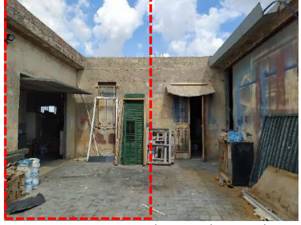
Foto n. 42: Ingresso da rampa lato strada
