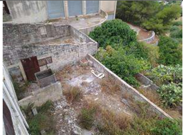
Foto n. 4: Terreno retrostante (p.lla 290)
