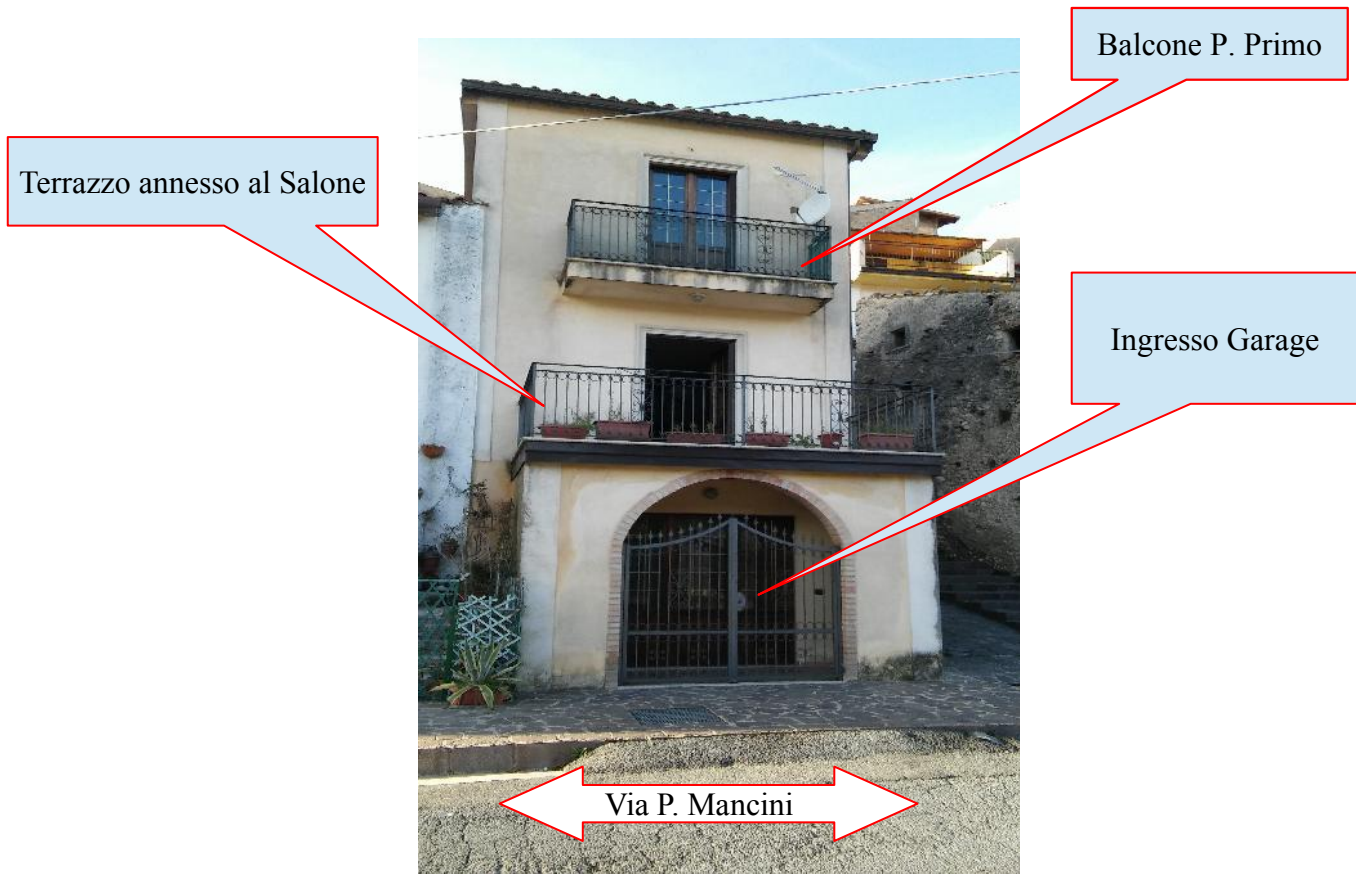
Foto n. 1 (Fabbricato lato Sud - Est)
