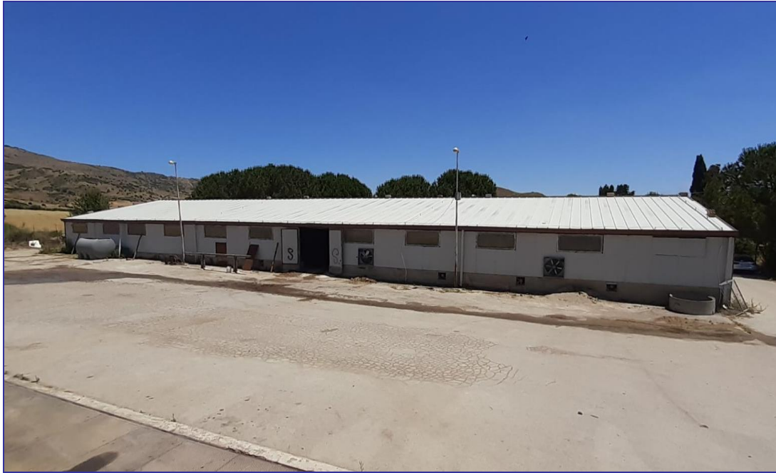
Foto 5 - Imm. 1 - Prospetto principale della stalla.
