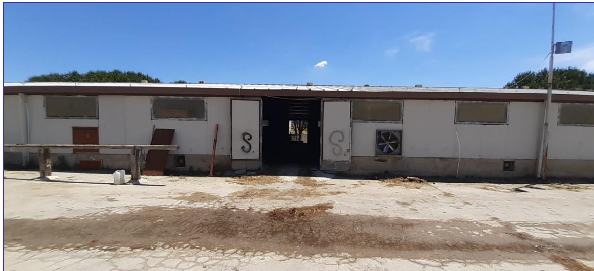
Foto 9 – Imm. 1 - Accesso alla stalla dal prospetto principale.
