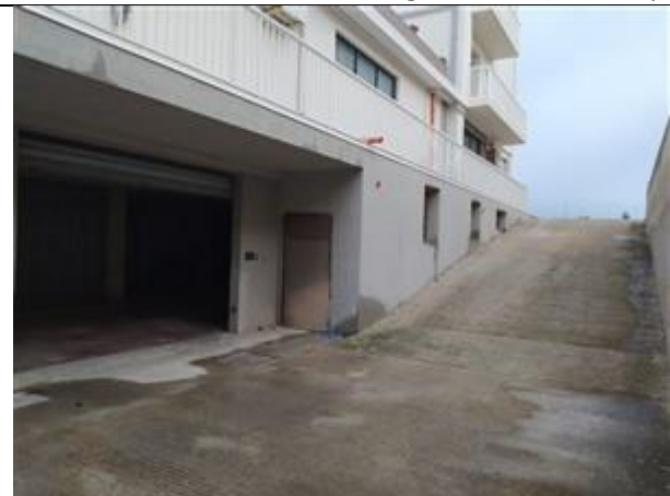
Foto n. 16: Scivola di accesso al piano interrato
