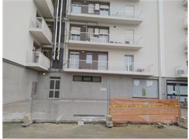
Foto n. 2: Prospetto lato ingresso condominiale
