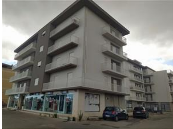
Foto n. 1: Prospetto visto dal piazzale esterno
