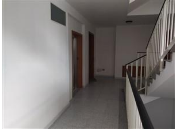
Foto n. 6: Vano scala piano appartamento
