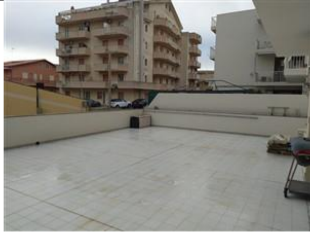
Foto n. 9: Area di pertinenza scoperta lato Ovest
