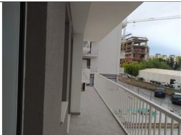
Foto n. 13: Balcone lato Est
