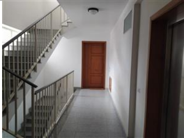
Foto n. 5: Vano scala piano appartamento
