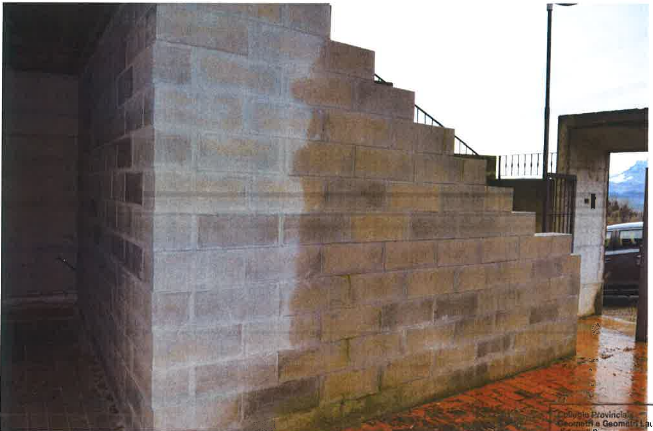
Foto n° 8: vista nuovo terrapieno su corte esterna realizzato in blocchetti in cemento.
