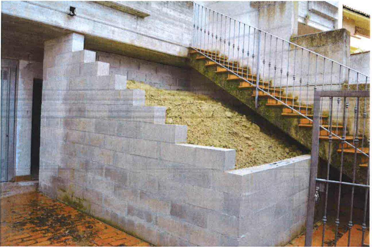
Foto n° 9: vista nuovo terrapieno su corte esterna (lato nord) realizzato in blocchetti in cemento.
