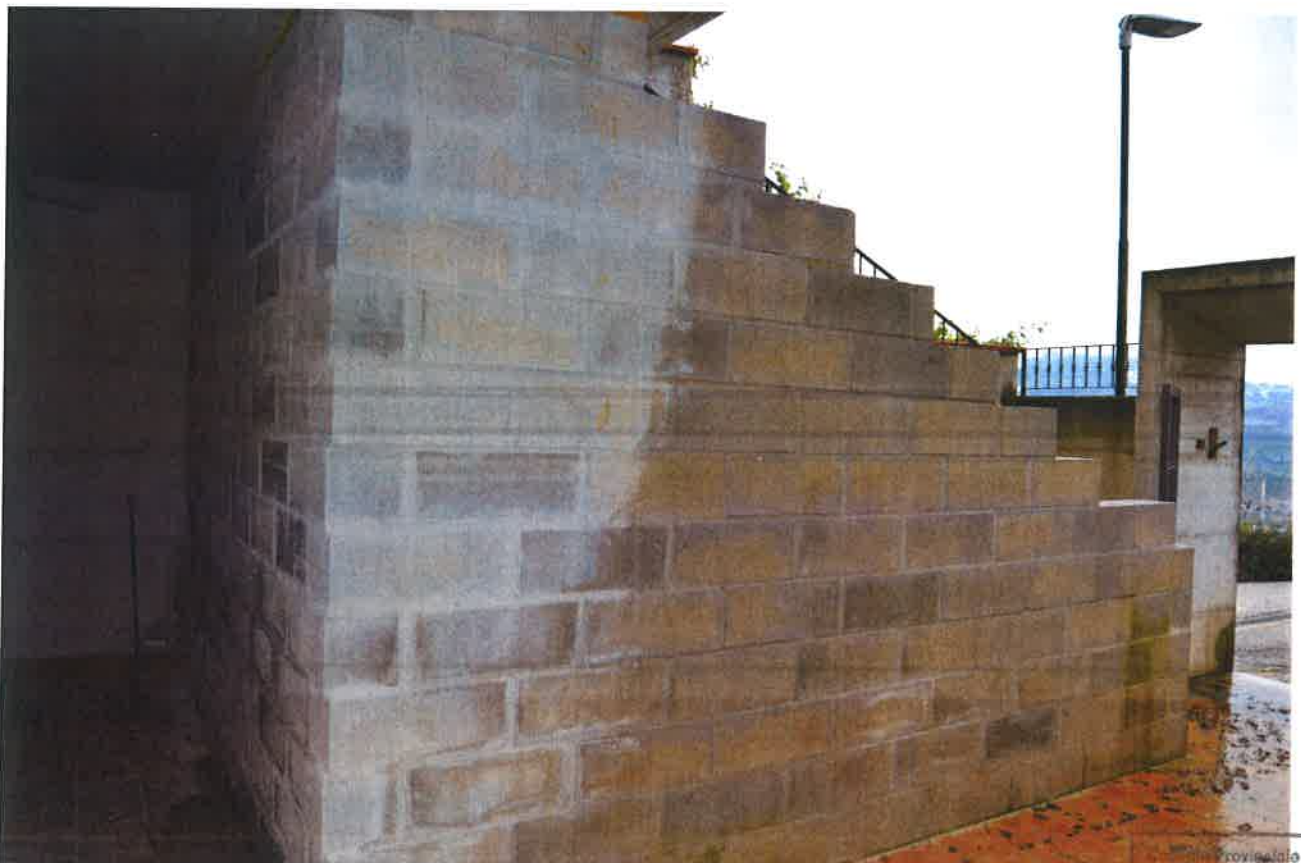
Foto n° 3: vista nuovo terrapieno su corte esterna realizzato in blocchetti in cemento.
