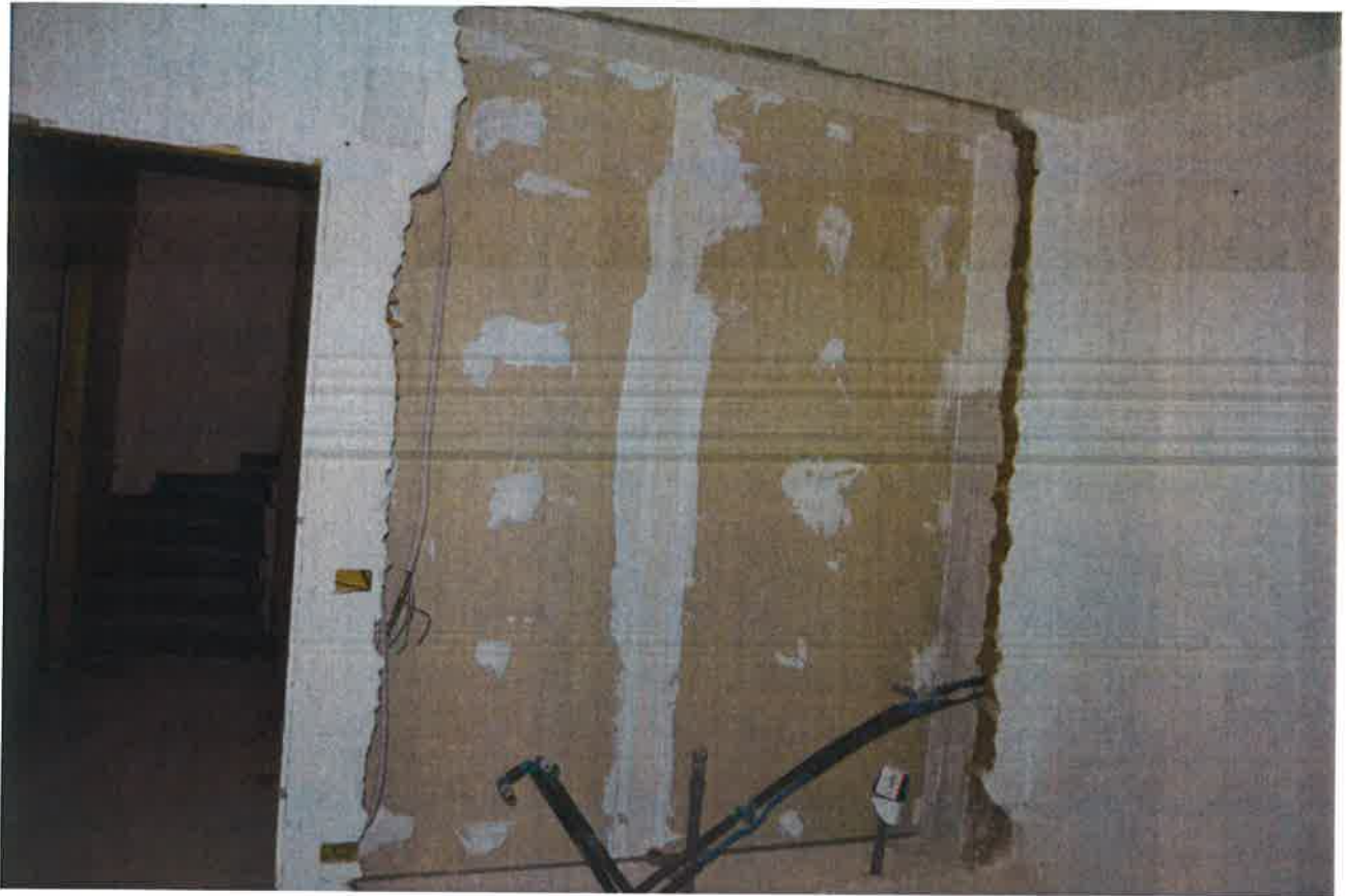
Foto n° 2: vista interna stesso divisorio demolito dal locale cantina.
