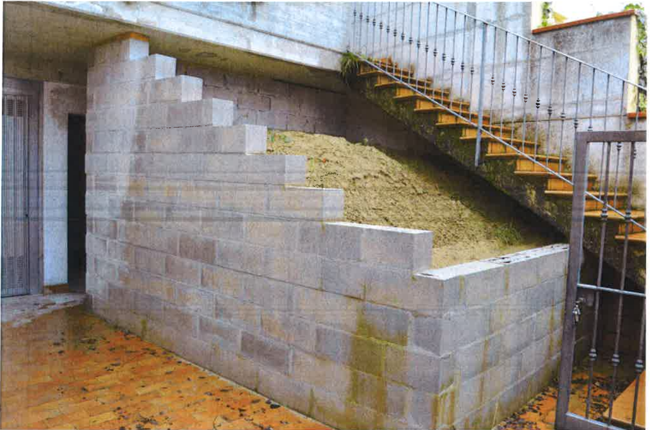
Foto n° 4: vista nuovo terrapieno su corte esterna (lato nord) realizzato in blocchetti in cemento.
