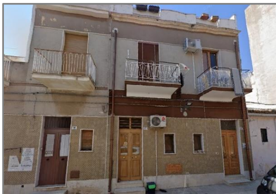
Foto del prospetto dell'abitazione
