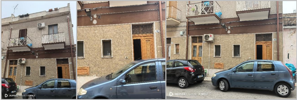
Foto con il prospetto principale dell'abitazione
