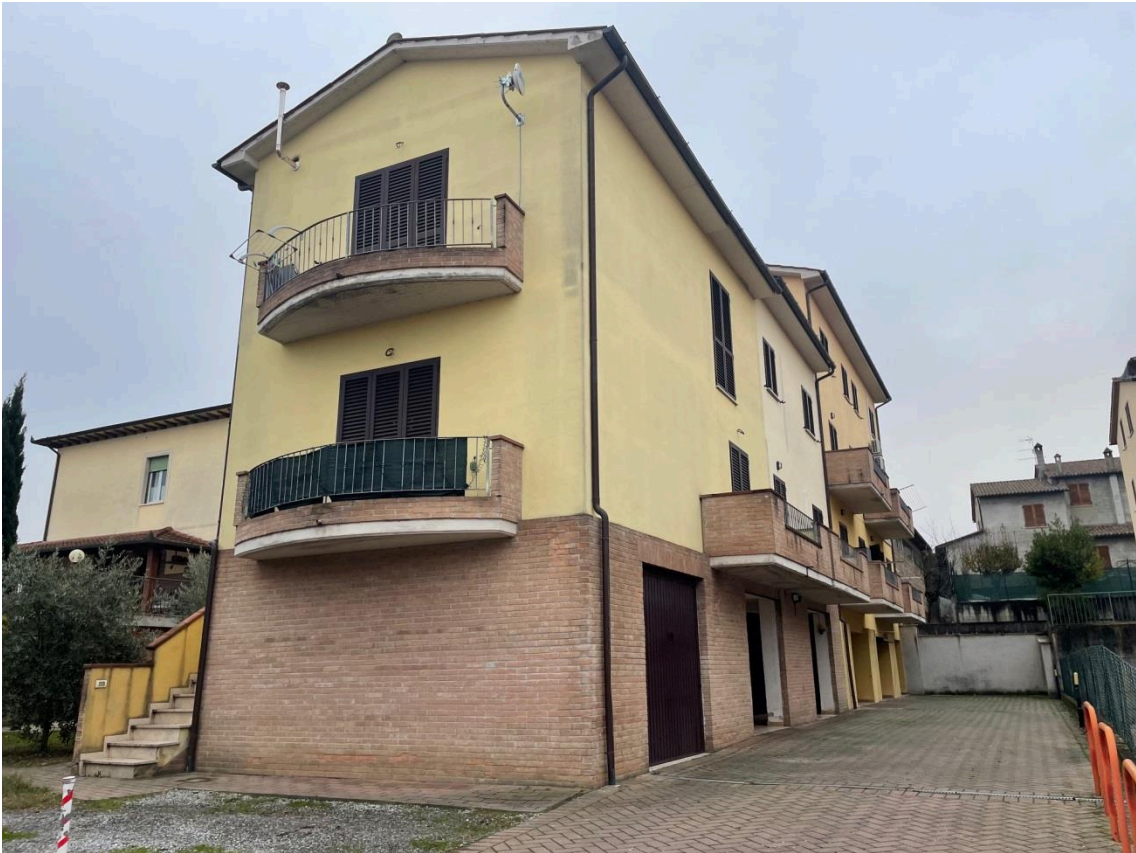
Vista edificio ospitante le u.i.u. oggetto di esecuzione
