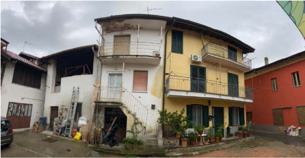
Foto 1: affaccio principale su corte interna lato ovest
